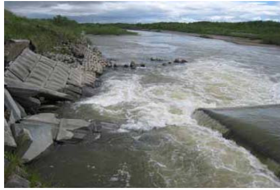
下流護岸工左岸部損壊状況(上流より)
