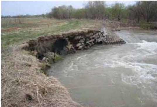
下流護岸工右岸部損壊状況(下流より)
