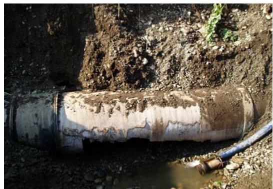
FRPM管破損管全景
