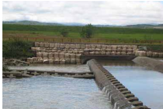
下流護岸工右岸部応急処置状況(左岸より)
