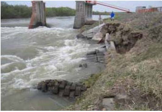
下流護岸工左岸部損壊状況(下流より)
