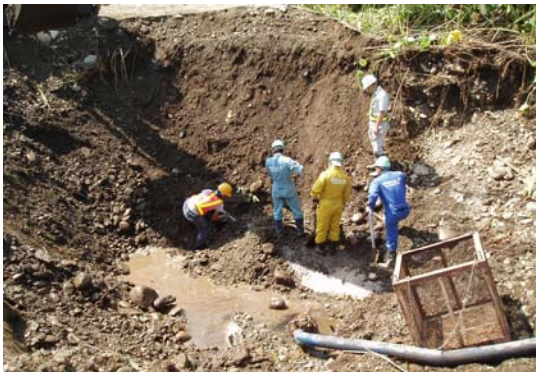
破損事故(漏水箇所)現地掘削状況
