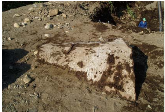
FRPM管破損片
