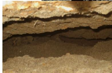
堤頂にダム軸方向の開口亀裂（5～50m長、8～26cm幅、1.4～2.5m深さ）
