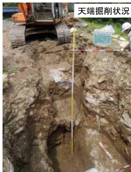
4.35m掘削で亀裂下限確認できず。
