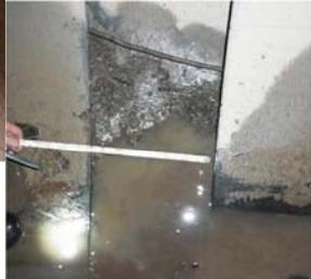
継ぎ手部の移動状況=大きく抜け出している
