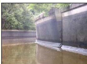
老朽化により傾倒している用水路
