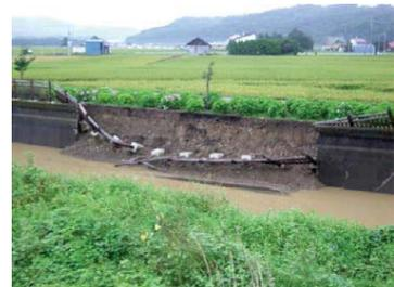
老朽化により倒壊した水路(H22. 8)
