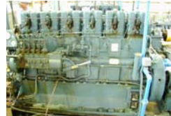
排水能力の低下(劣化及び油漏れ) ●運転停止に伴う湛水被害の懸念
