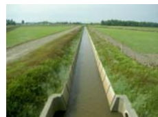
排水路の整備(イメージ) ●流出能力を確保し被害を解消
