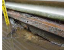
排水路の能力低下(腐食による開孔) ●断面障害・流水障害の懸念
