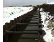
排水路の能力低下(護岸のはらみ出し) ●断面障害・流水障害の懸念
