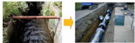
水路の更新(開水路→パイプライン)
