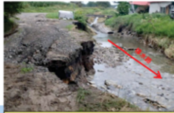
清水町: 排水路の被災(護岸の流失)
