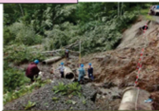
上富良野町: 用水路の被災(地盤陥落による管水路の破損)
