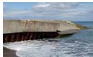
《 河口施設 右岸部の倒壊事故 》
