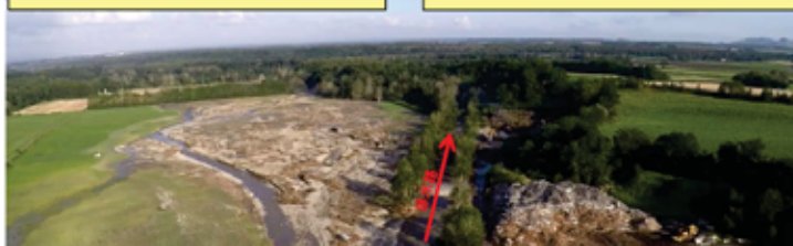
清水町: 農地・排水路の被災(農地への土砂等の流入、護岸・法面の流失)
