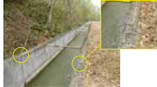
用水路の側壁傾倒（倒壊寸前）
