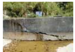
ダム洪水吐のコンクリートのひび割れ
