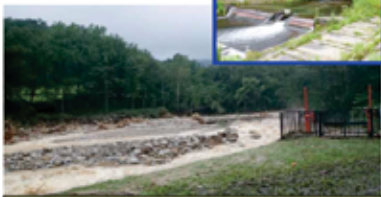
清水町: 頭首工の被災(施設全体が流失)
