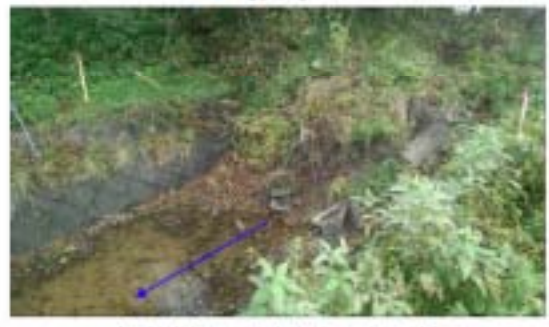
【土砂崩れによる水路断面の閉そく】
