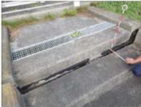
【ダム堤体天端下流部の間口】
