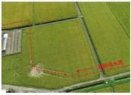
【管水路損傷による漏水】
