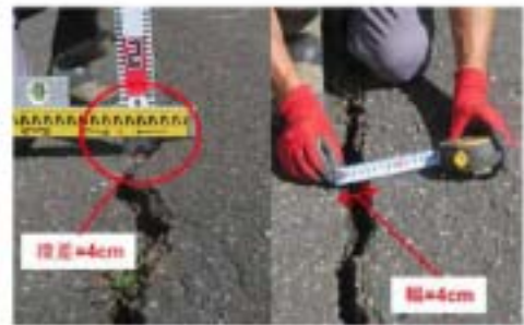
【ダム管理用道路亀裂】
