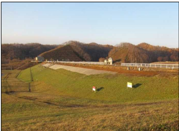
瑞穂ダム堤体の復旧完了
