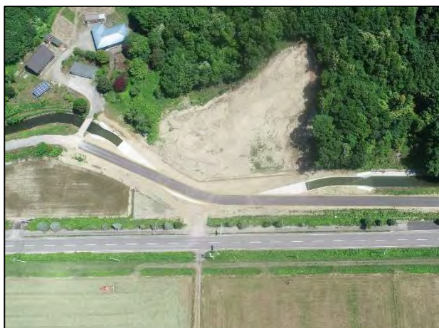
川西幹線用水路の復旧完了
