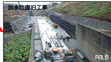
厚真ダムの被災直後と復旧工事状況
