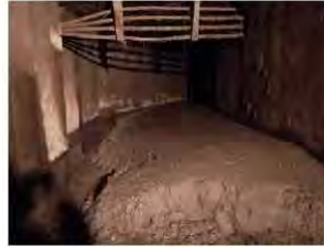
用水施設の取水阻害(南美原揚水機)
