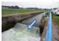
発電地点（設置前）
