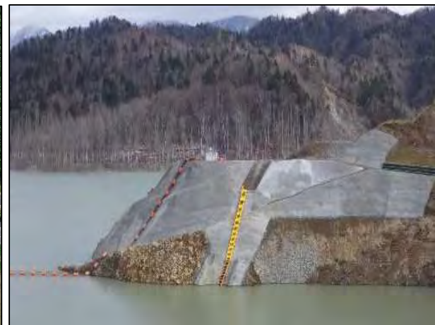
夕張シューパロダム貯水池法面の復旧完了
