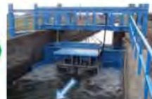
発電施設（設置後）
