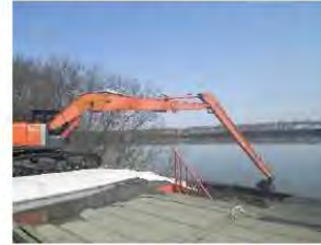
用水施設の取水阻害(南美原揚水機)
