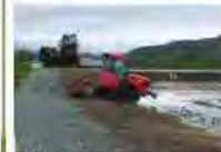
農機の旋回を容易にし、作業効率を向上させるターン農地の整備
