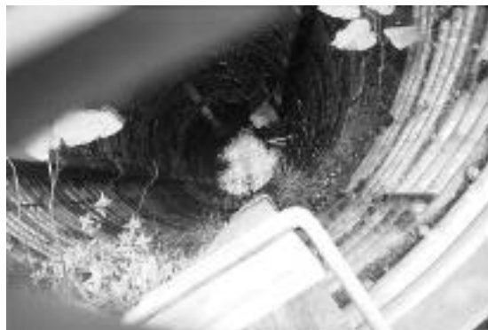
地すべり対策事業ルーク地区 集水井工
