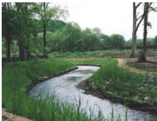
自然の流路を生かした排水路 【チグサ藻琴川にて撮影】
