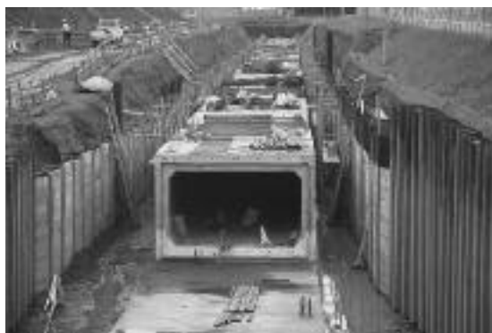
浦臼排水路工事現場
