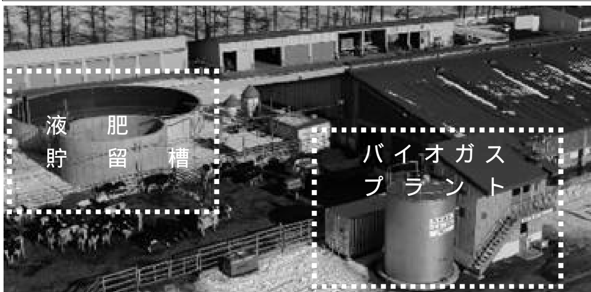
帯畜大/三井造船バイオガス共同研究設備
