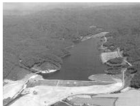
完成当時の瑞穂ダム全景
