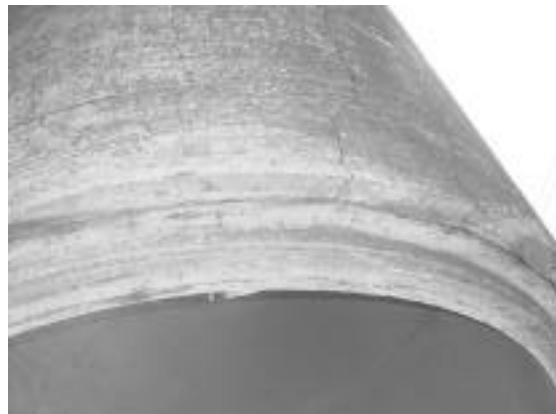
写真-2 長年の暴露試験により劣化した管体コンクリート
