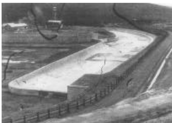
余水吐溢流部付近完成状況
