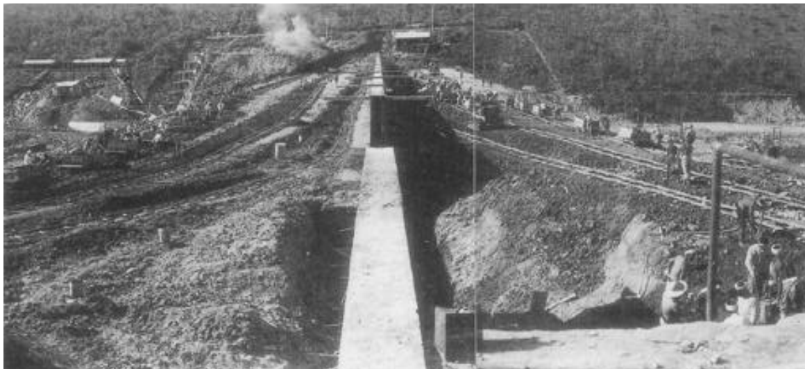
鉄筋コンクリート中心壁の両側を盛立中(右岸より左岸を望む) 運搬機械は蒸気機関車、トロッコ使用
