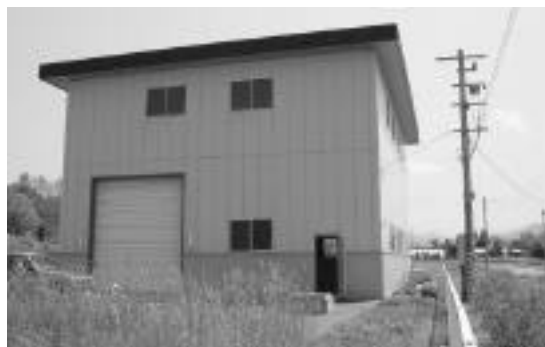
三笠揚水機場
