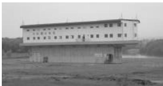
中村揚水機場
