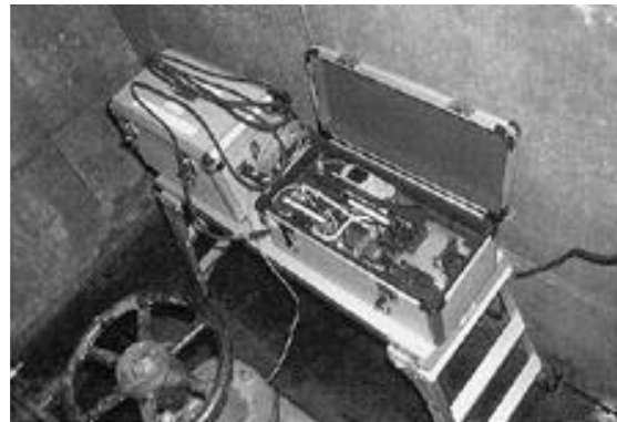
現場側(携帯電話、ロガー、バッテリー)
