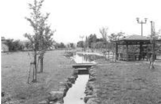
北海幹線水路高度利用 美唄地区水環境整備 (美唄市東3条北1丁目付近)
