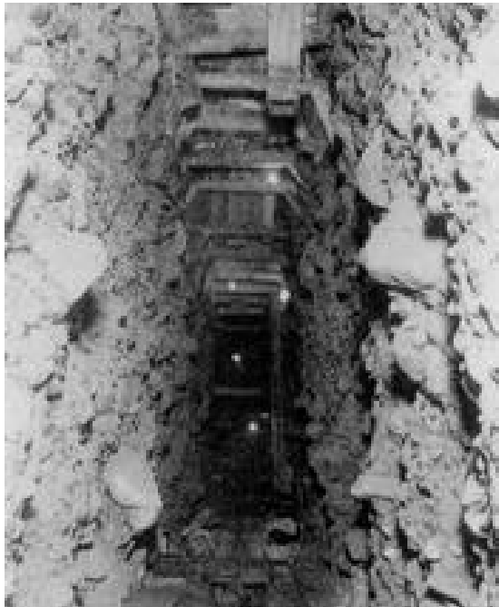
右岸段丘心壁土砂部横坑掘削支保工
