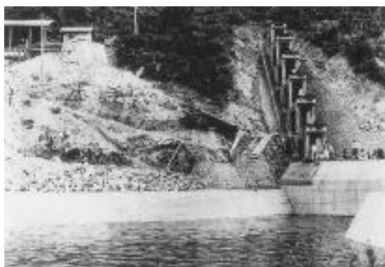
斜樋構造全景
