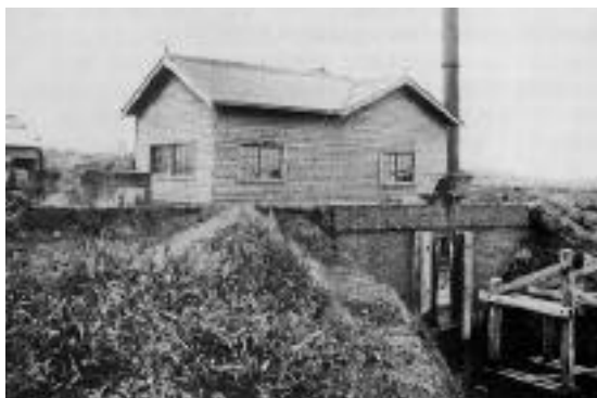
大正11年 当麻内土功組合設置 かんがい揚水機場
