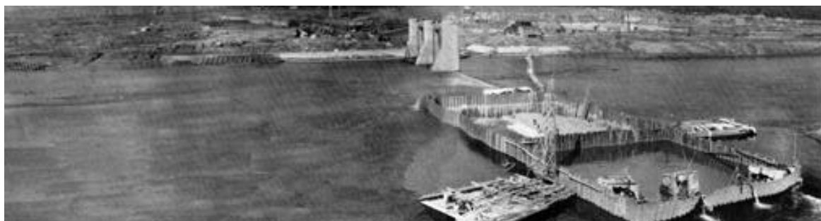
堤体施工状況(ブロック据付河床掘削)
