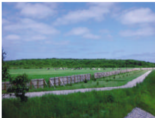
浄化型排水路
