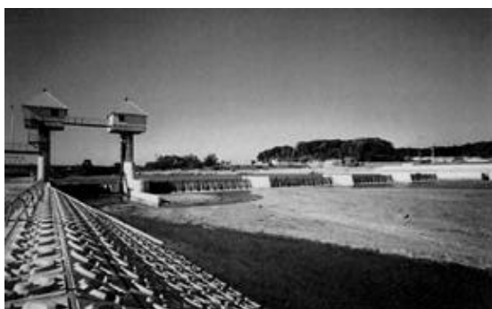
平成6年北海道補償工事で完成
