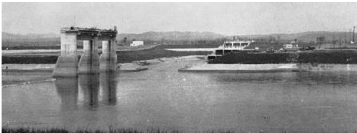
写真1 石狩川頭首工
