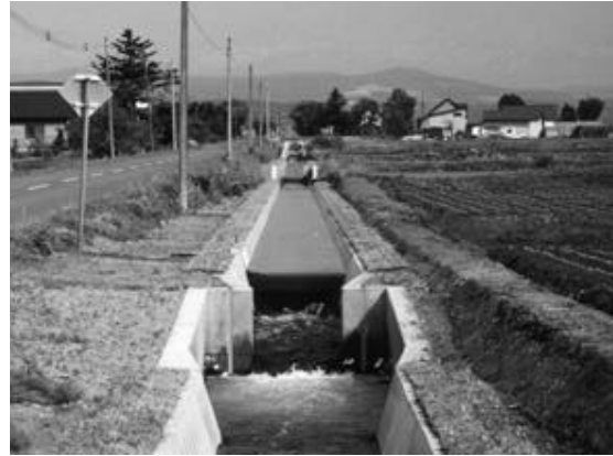
国営かんがい排水事業 第4支線完成
