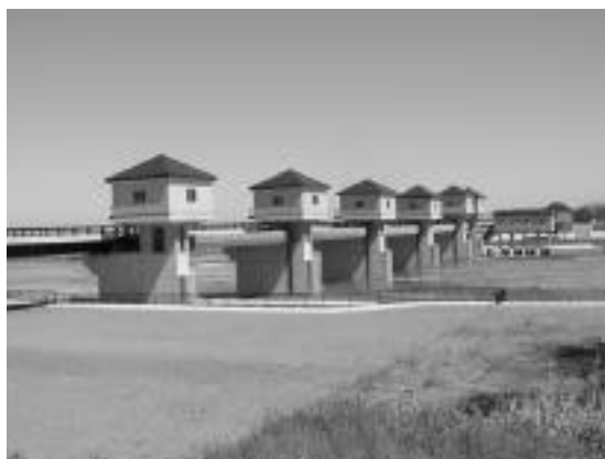
国営かんがい排水事業 新第3頭首工完成
