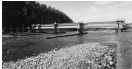
忠別川第2頭首工の全景
