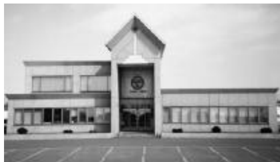
新事務所・中央管理所(平成8年)
