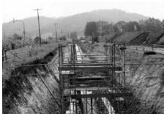
パイプラインの建設工事現場
