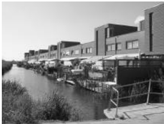
水路と接する住宅のベランダ
