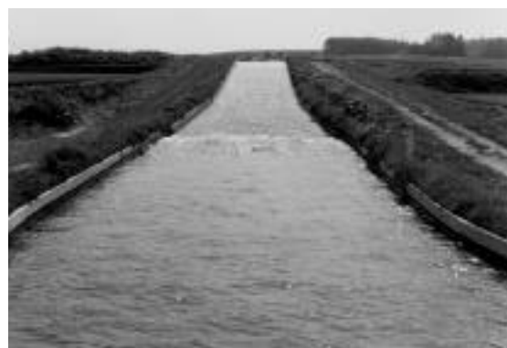
高台幹線用水路(広幅水路)上流部から下流を望む
