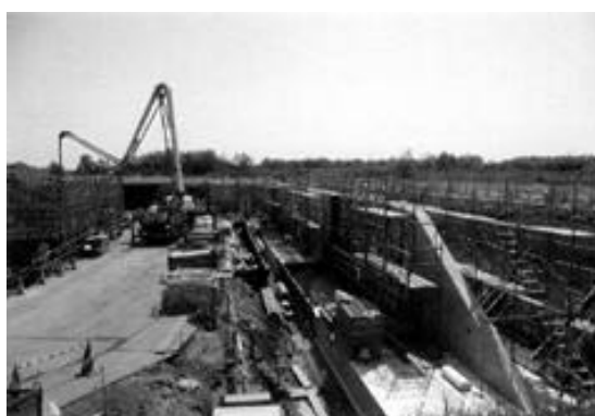
豊北排水機場建設現場
