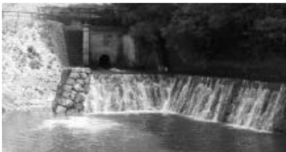
写真-2 満濃池樋門
