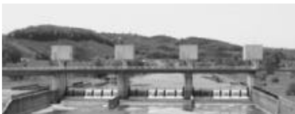
常呂川第1頭首工
