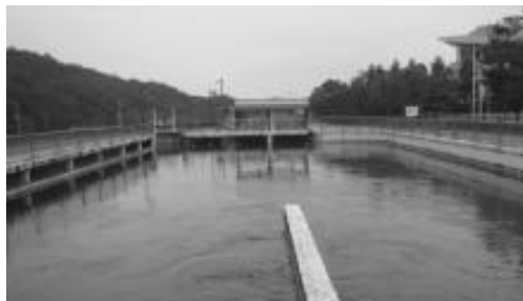
写真-6 東西分水工
