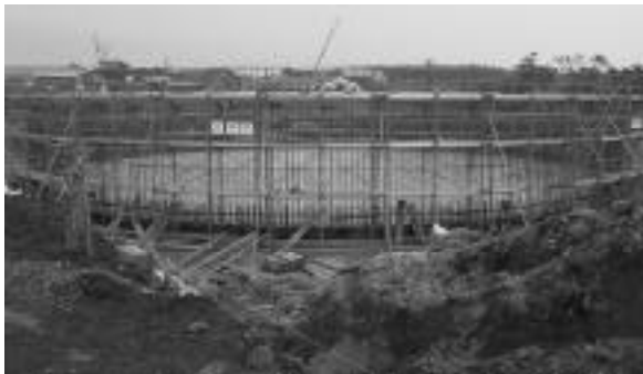
配水調整槽建設現場
