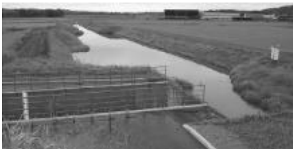
完成後の沈砂池
