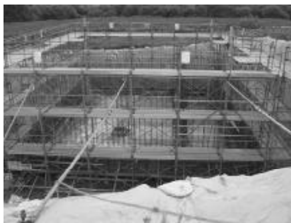
調整槽建設現場
