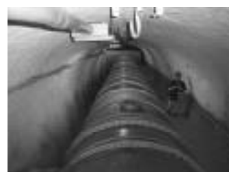
リベット接続の鋼管
