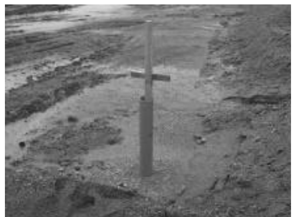
置土工(沈下板設置状況)
