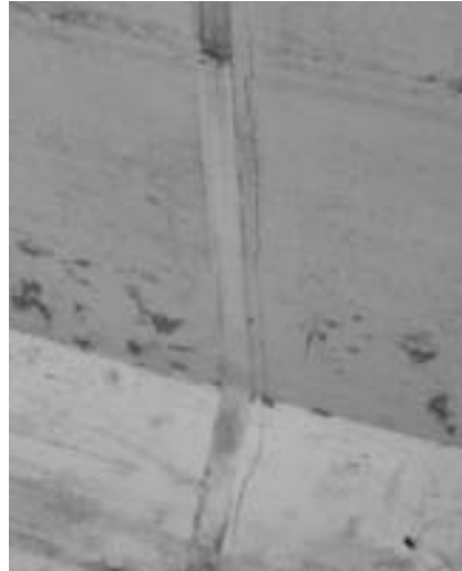
写真-9 目地脇に発生したクラック
