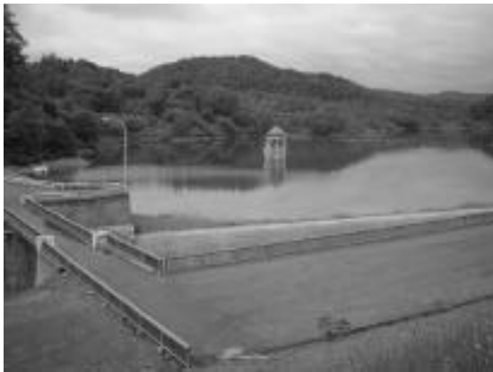
羽幌二股ダム
