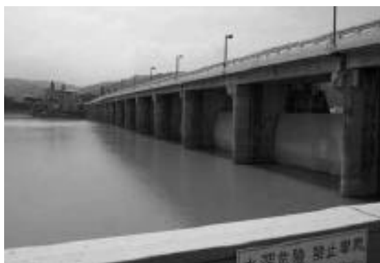
写真 9 石岡ダムの全形
