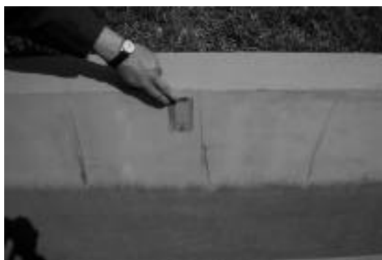
写真-2 縦方向にクラックの入った状況
