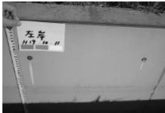
写真-10 アンカー部からモルタル材が流出
