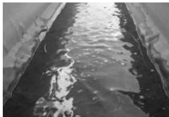
写真-5 ハンチ、底版部のふくれ
