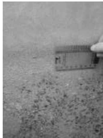
写真-4 摩耗した状況
