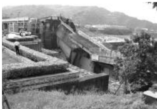
写真 10 石岡ダムの破壊されたゲート
