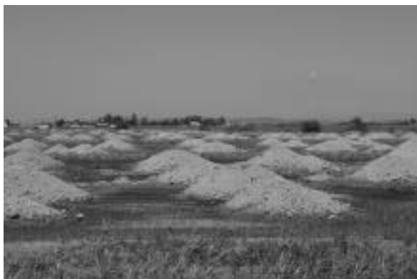
東三川北工区区画整理建設現場(客土材搬入状況)
