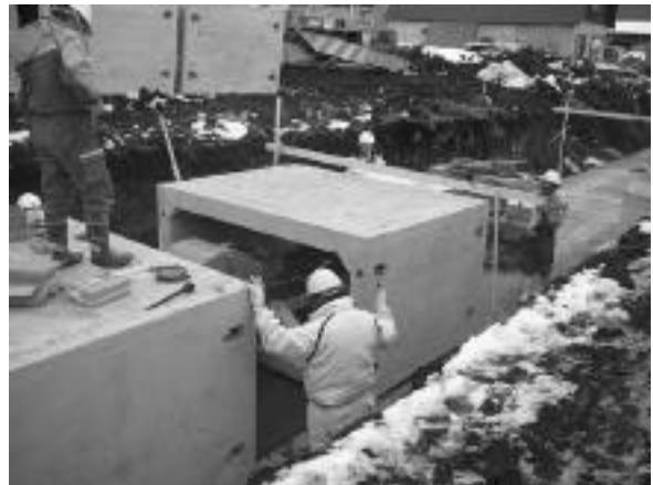
国営大野平野地区による施設改修工事
