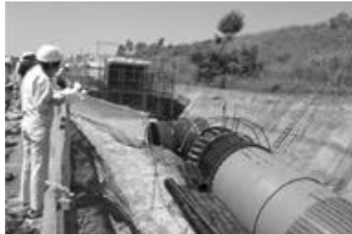
写真-1 「FRPM管とホロカ調整工の接続部」
