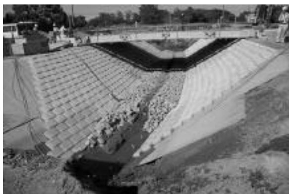
旭用水路外一連建設現場(新排水路施工現場)
