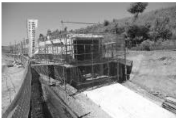
道央用水(三期)地区建設現場(ホロ力調整工)
