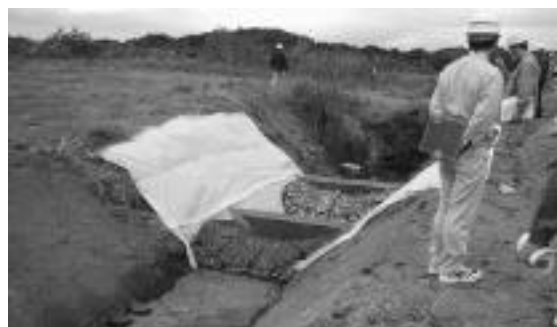
濁水処理施設状況
