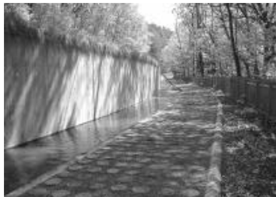
山手幹線水路と地域用水としてのせせらぎ水路
