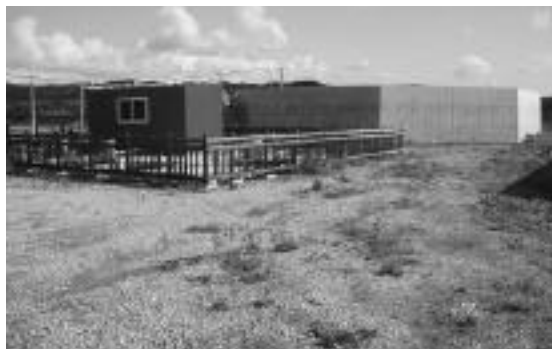
幌進地区 肥培かんがい施設
