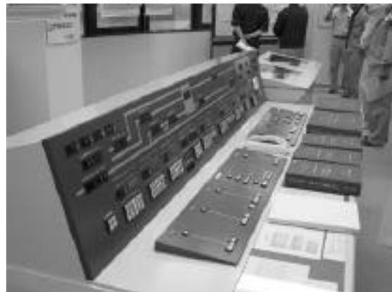
写真-5 共和ダム内部操作パネル
