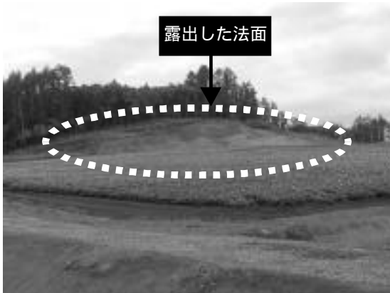
写真-3 真狩南部工区
