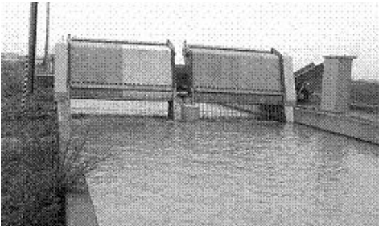
国営かんがい排水事業「由仁幹線水路（除塵機）」
