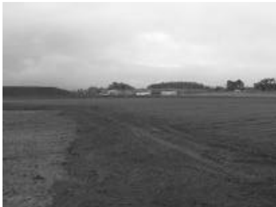
写真-1 川崎中央工区(施工中)
