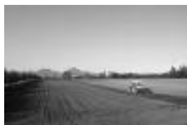
夫婦山を背景に整地作業 (JA鹿追HPより)
