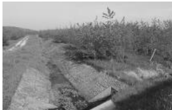
図-3 B地域における土砂緩止林の整備例
