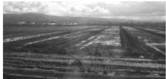
妹背牛地区(面整備と暗渠を施工中)
