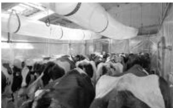
写真8 - 上部のビニールダクトから冷風が出て、牛を冷やす雪氷冷房システム
