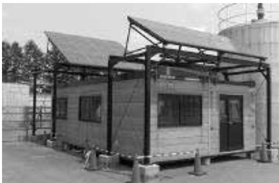
写真3 - 太陽光モジュールの設置状況
