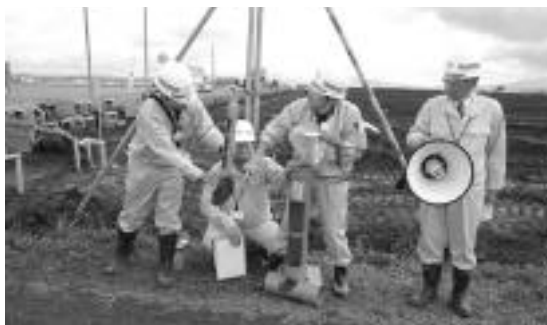
水位調整型水閘管の説明状況
