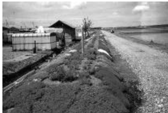
環境に配慮した管理 埋設管水路の盛土部分に芝桜を植栽
