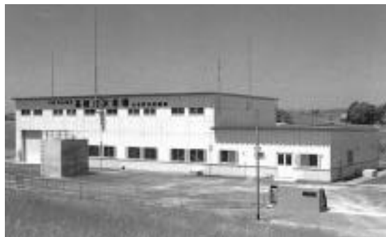
基線揚水機場
