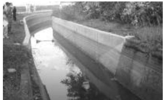
てしおがわ地区(手前：既設水路、奥：改修水路)
