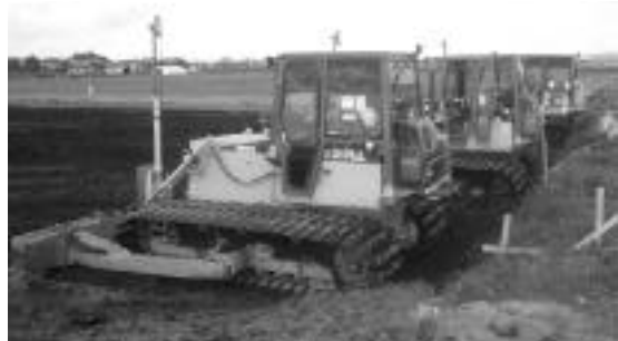
富良野盆地地区 西徳西工区工事
