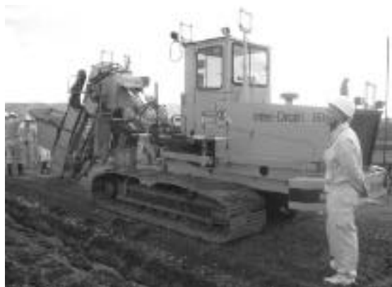
富良野盆地地区 宇文北工区工事
