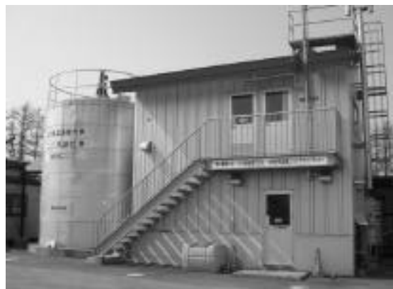
写真1 - バイオガスプラントの外觀
