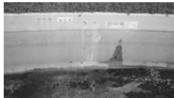
ポリウレア樹脂の確認跡（後日補修予定）
