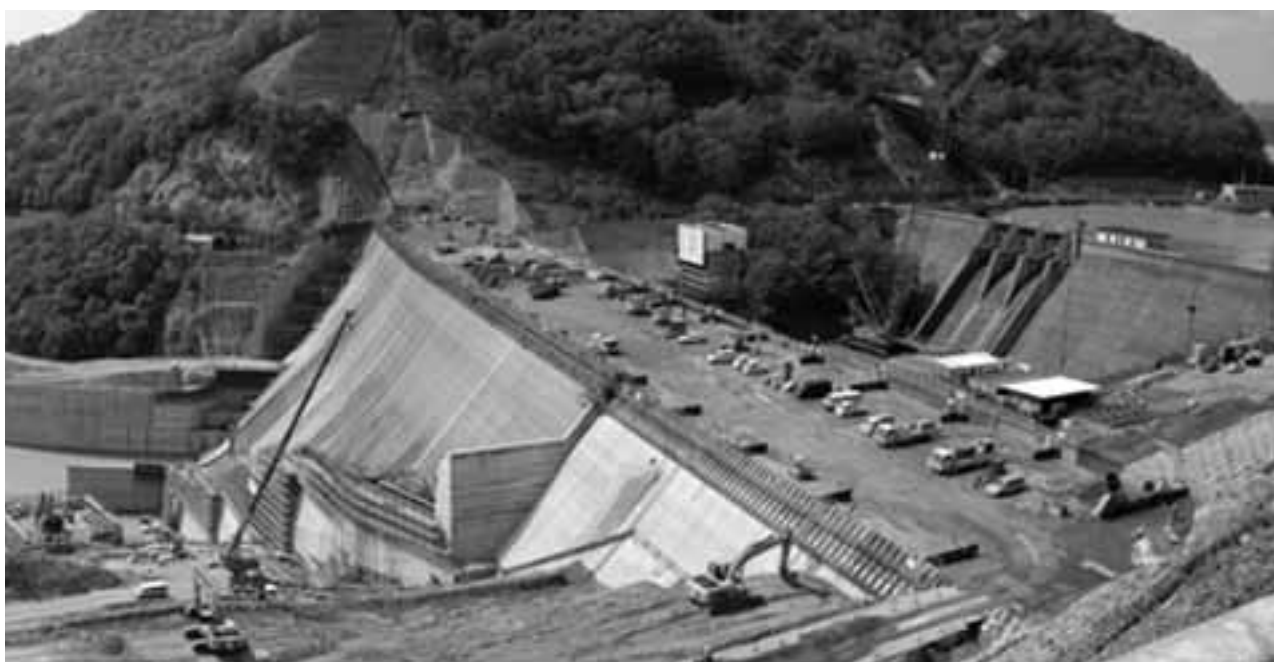
建設が進む夕張スーパーダム(H23.6)
