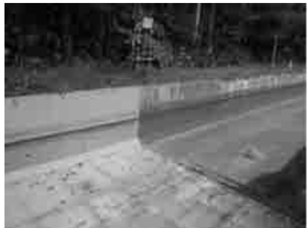
▲FRPM 板の補修と現況用水路の境
