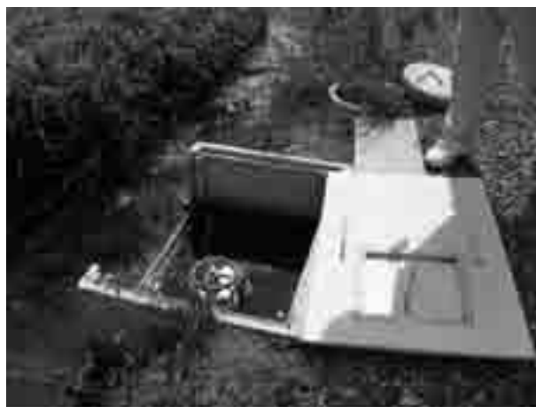
▲完成ほ場の給水栓
