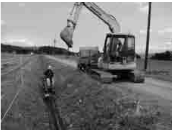
排水路の清掃状況
