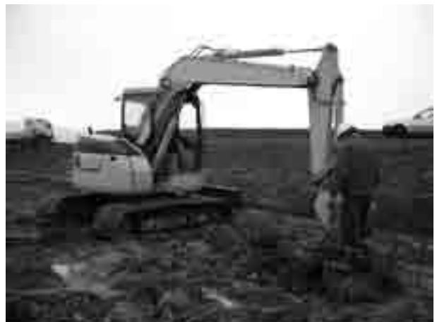
パイプライン補修状況
