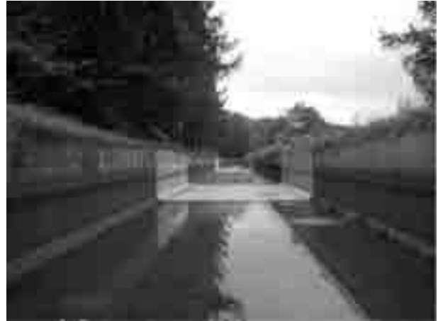
▲試験施工現場(用水路内から撮影)
