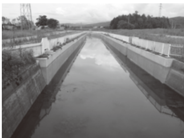
写真-8 改修後の北海幹線水路
