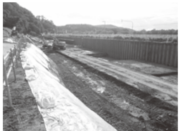
写真-6 北海幹線用水路 改修状況
