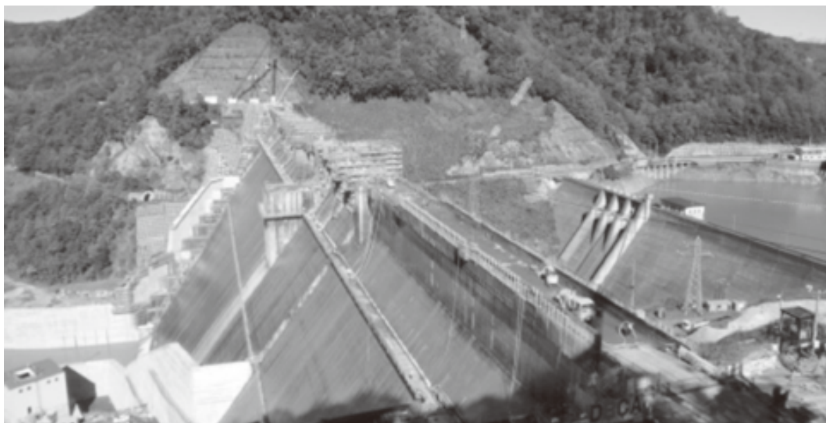
完成が近い夕張シューパロダム(H24.10)
