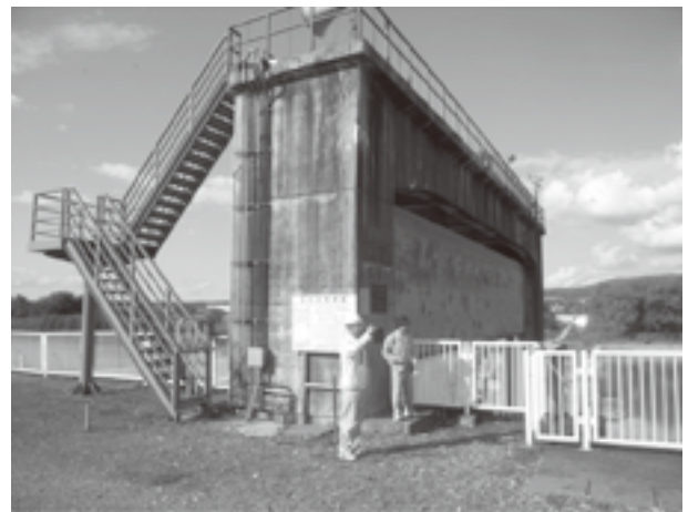
▲ 北海(一期)地区: 北海頭首工研修現場
