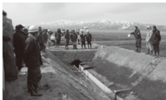
写真-7 フラッシング操作の説明状況
