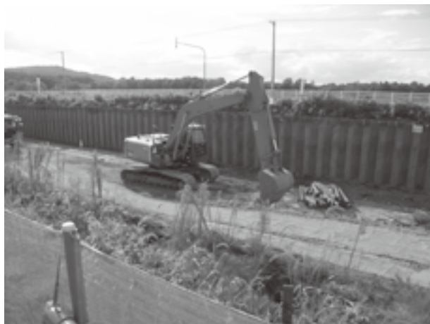
▲ 北海(一期)地区:北海幹線用水路
