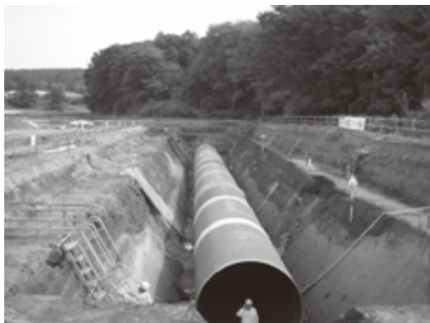
工事が進む道央注水工
