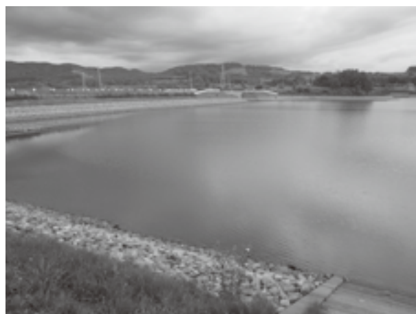
写真-9 光珠内調整池
