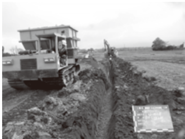
火山礫の被覆材による暗渠
