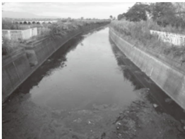
写真-7 改修前の北海幹線水路
