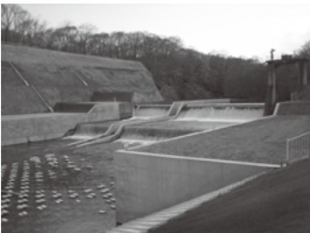
漁川第1頭首工
