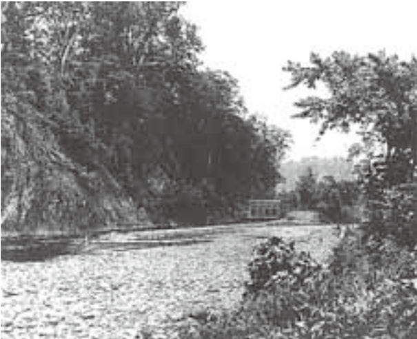
尾白利加川導水門
