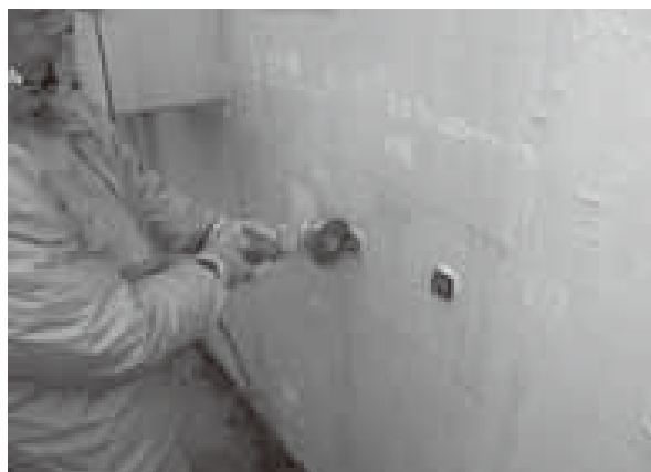
(コアスリット状況)
