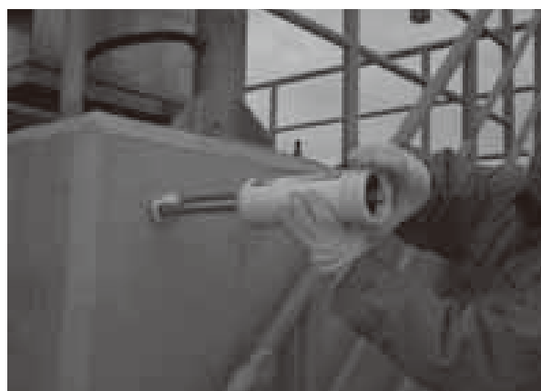
(孔内撮影状況)
