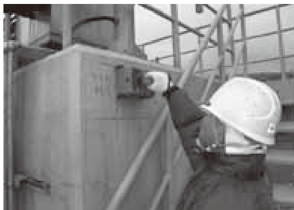
(削孔前:鉄筋探査状況)
