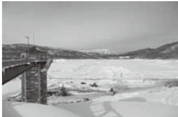
腐葉堆積土の搬出作業
