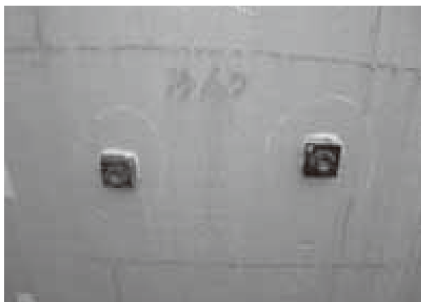
(試験治具設置状況)
