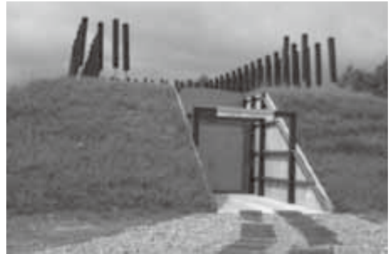
写真-4 テクノファーム実用凍土低温貯蔵庫
