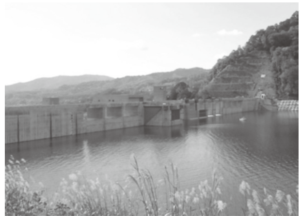
写真-3 夕張スーパーダム
