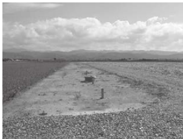
写真-2 整備後のほ場と用水施設
