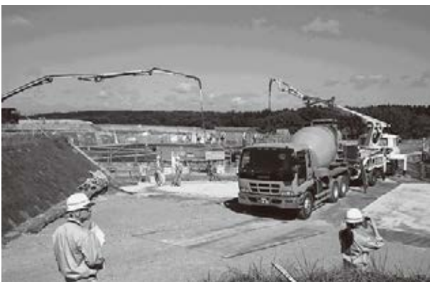
建設中の配水調整槽
