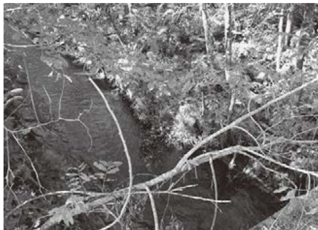
改修予定の排水路
