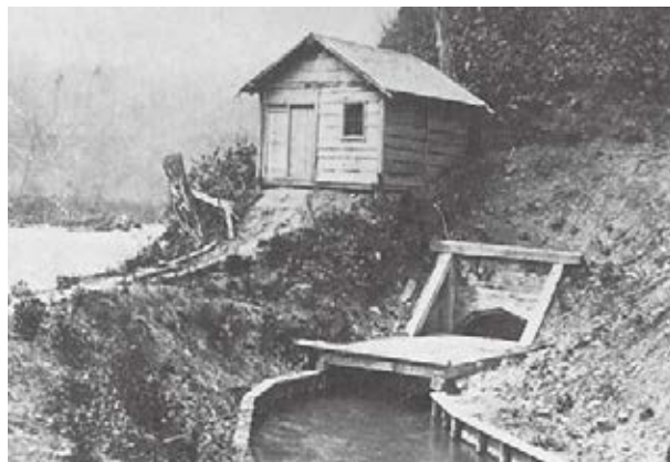
上徳富土功組合取水口(明治42年)
