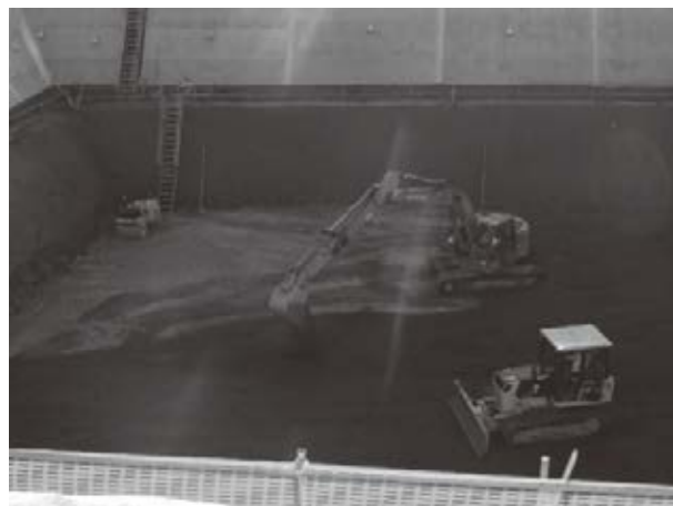
写真-5 基礎工施工状況
