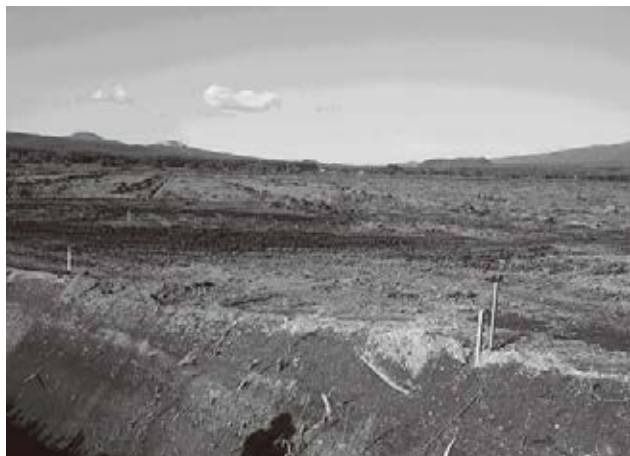
農地保全工事施工状況
