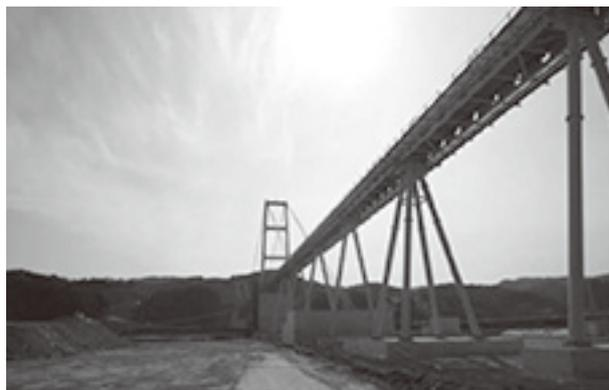
巨大土砂運搬ベルトコンベアー
