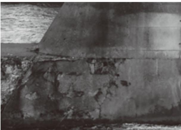
写真-3 コンクリートの劣化部分
