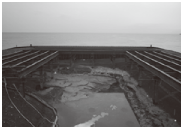
写真-2 日本海突出部の二重締切工（上流から下流を撮影）
