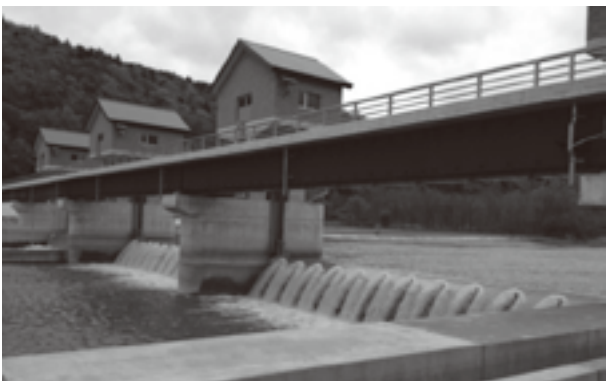
国営総合農地防犯事業で改修された空知川頭首工
