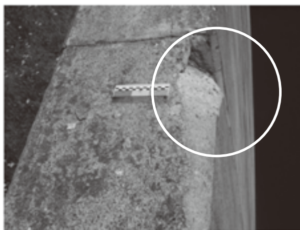
写真-4 洪水吐静水池左岸 欠損
