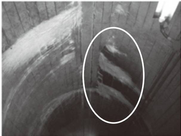
写真-5 監査廊ひび割れ、エフロレッセンス
