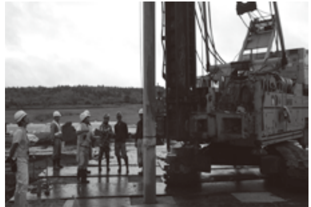
写真-5 11号排水路のくい打ち状況
