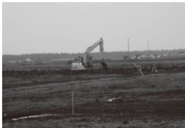
写真-4 暗渠排水施工現場状況
