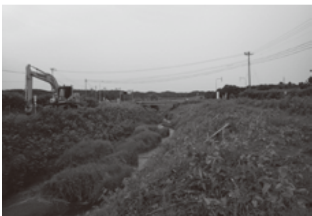
写真-3 6号排水路状況
