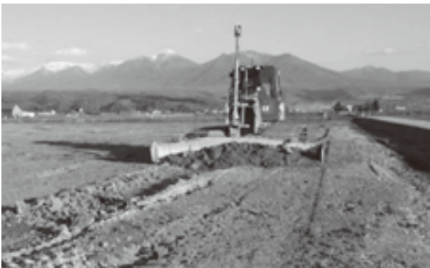
国営農地再編整備事業による整地工施工状況
