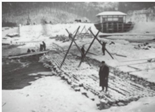
昭和30年頃の山手幹線導水門災害復旧工事
