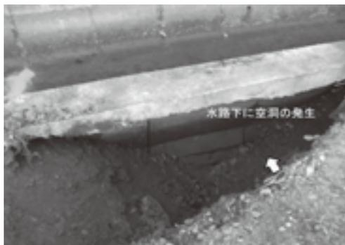
図-9 水路下の空洞化と地盤陥没状況
