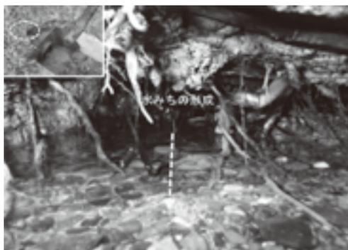
図-8 横断管上の水みちの形成状況
