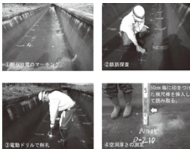
図-21 削孔調査状況
