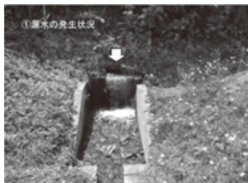
図-3 漏水の発生状況
