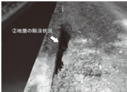
図-4 側壁後背の地盤の陥没状況
