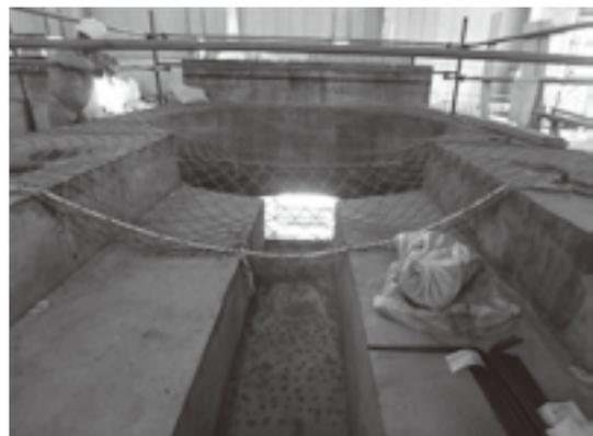
写真-2 ポンプ据付け台(吸込水槽方向)
