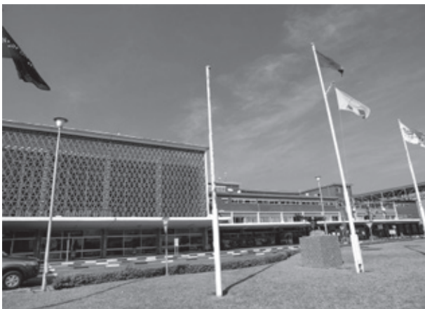
写真-6 ルサカ国際空港
