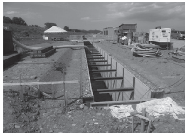
写真-1 第1幹線排水路の施工状況
