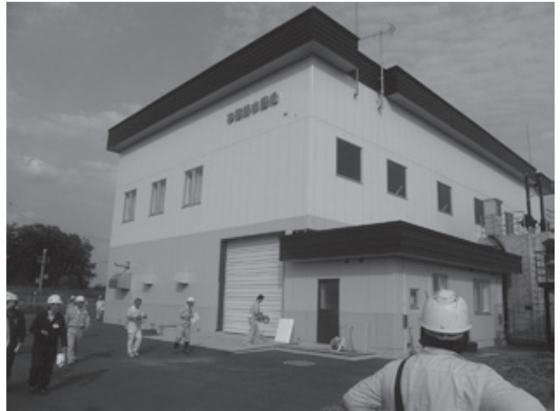
写真-3 本郷排水機場
