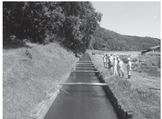
写真-6 用水路維持管理の切梁設置状況
