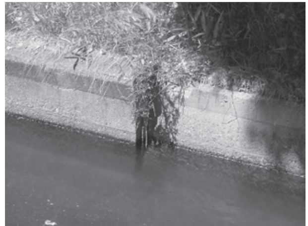
写真-5 西幹線用水路の目地部開き状況
