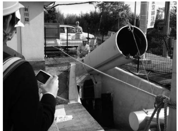
既設管内に新設の鋼管挿入状況 (写真 1)
