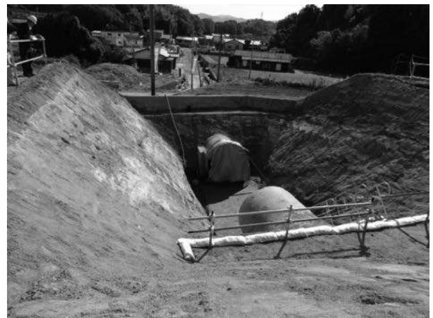
既設管の掘削状況 (写真 2)
