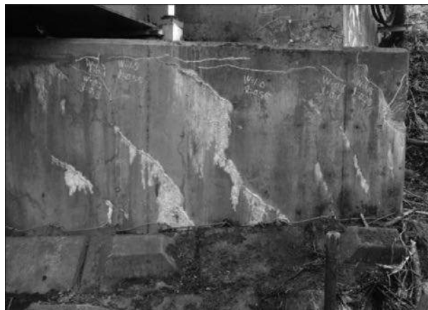
写真-1 A2橋台の遊離石灰
