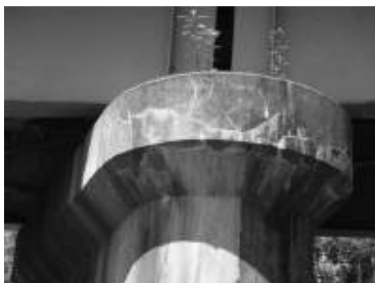
写真-3 P1のひび割れおよび遊離石灰
