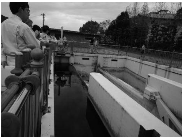
東西分水工（表面被覆工（有機系））を実施
