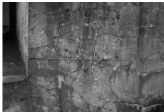
写真-5 A2側面の亀甲状ひび割れ
