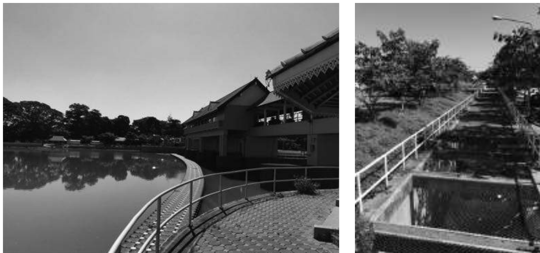
写真2 チェンマイ ターワンタ頭首工と魚道
