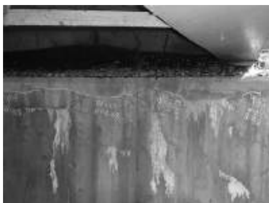
写真-4 A2のひび割れおよび遊離石灰
