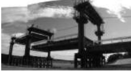
【ジャッキアップ工法】
