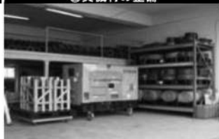
②資機材の整備
