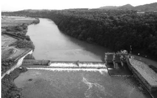
▲上空より長沼頭首工全景を望む
