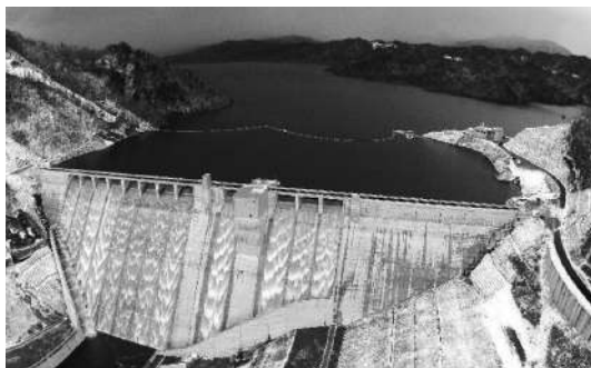
▲上空より夕張シューパーダム全景を望む
