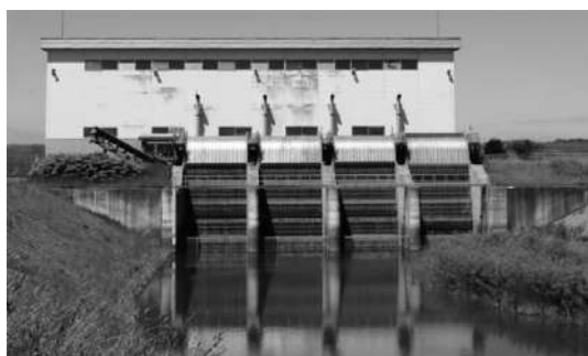
写真-1 排水機場正面
