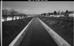
④水路改修
