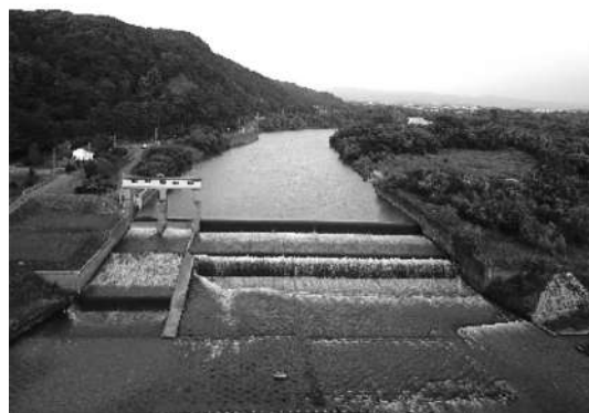
▲上空より栗沢頭首工全景を望む
