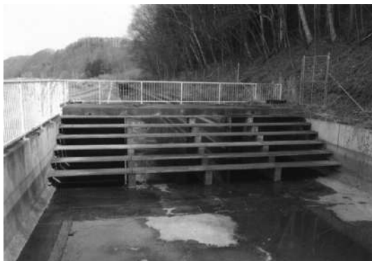
▲栗山幹線用水路(侵入鹿 這い上がり用階段)
