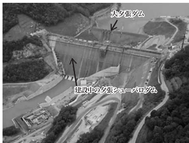
建設中の夕張スーパーダム
