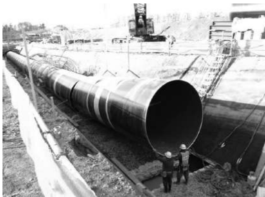
▲道央注水工の管水路の布設
