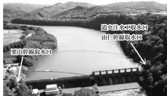
▲上空より川端ダム頭首工全景を望む
