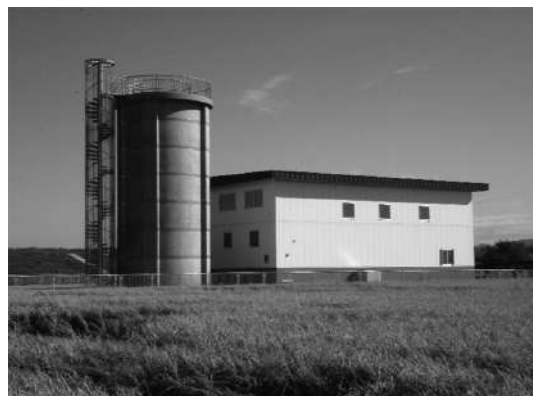
▲千歳川第1揚水機全景(機場、吐出水槽)
