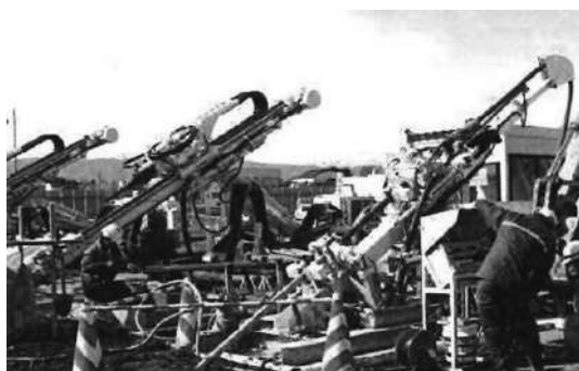
写真-3 削孔機(左)と注入機(右)
