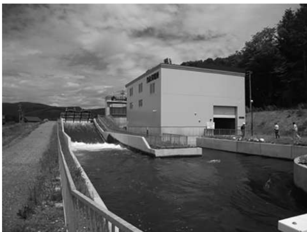
写真-2 落差工を利用した小水力発電施設（当永発電所）
