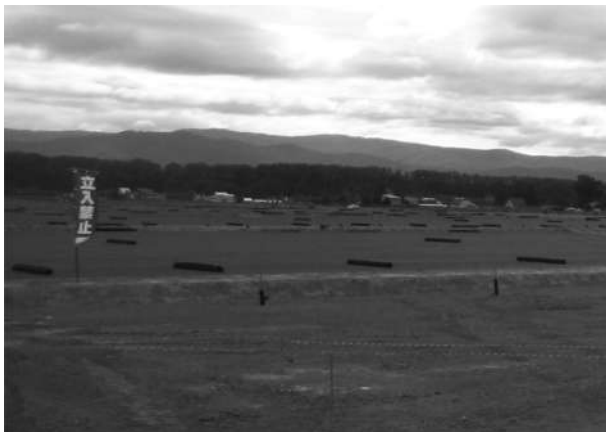
写真-5 区画整理工事状況(暗渠排水工準備)
