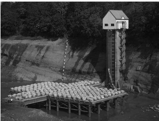
写真-1 工事用道路（仮栈橋）
