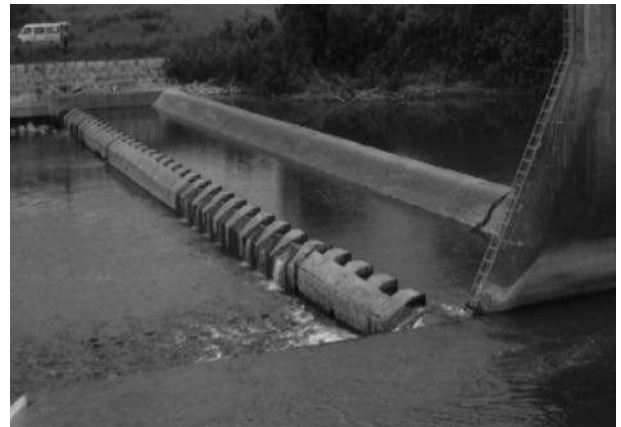
写真-2 護床工の低下状況 (上:平成14年撮影、下:平成25年撮影)
