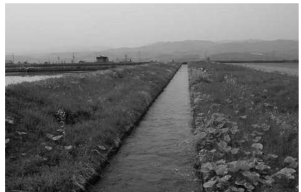
西幹線用水路
