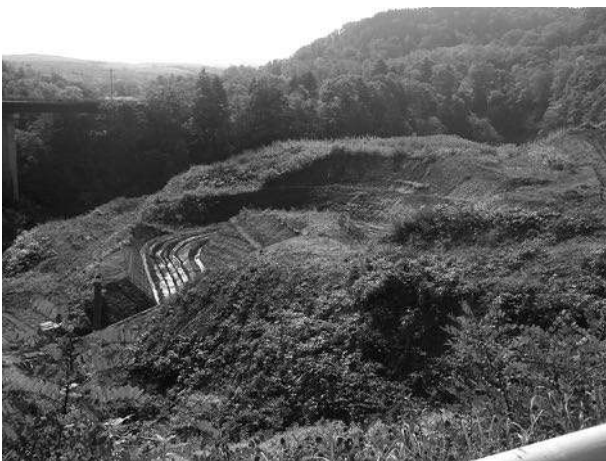
写真-2 工事用道路（盛土+掘削）
