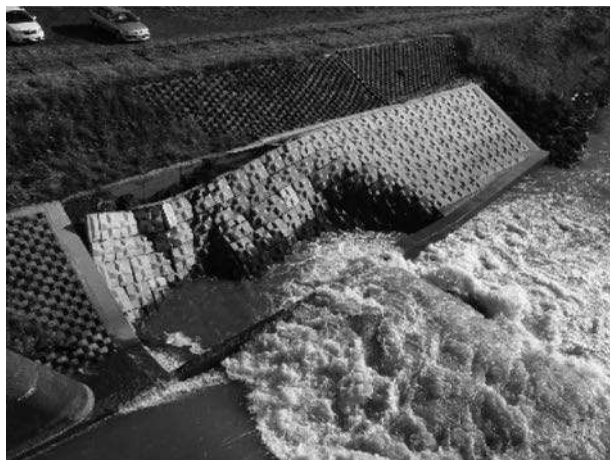
写真-3 左岸護岸工の被害状況(平成23年)
