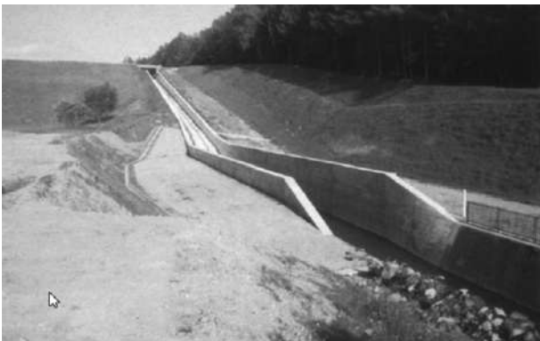
施設整備事業により改修した洪水吐工
