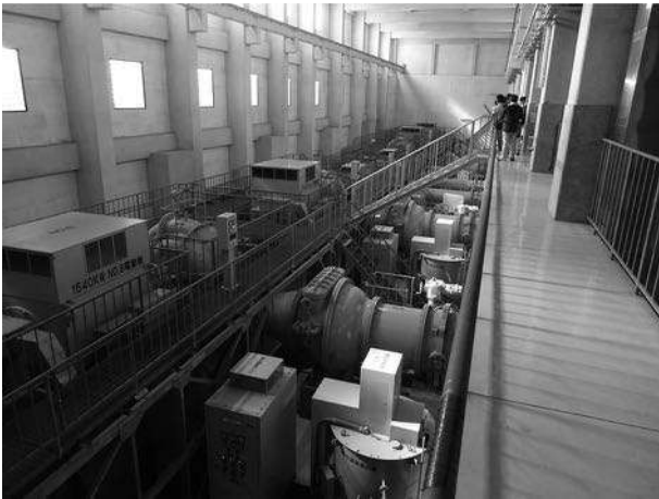
佐賀機場内ポンプ施設を望む
