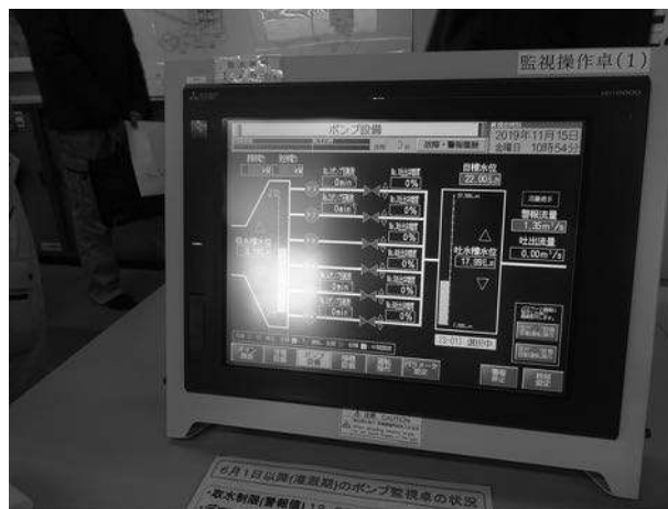
監視モニターにおける配水管理
