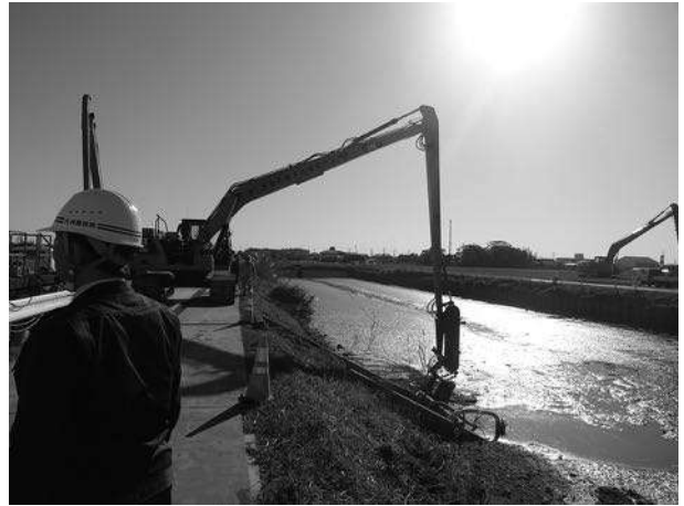
地盤改良状況
