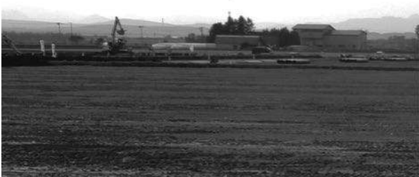
写真-5 用水路施工現場
