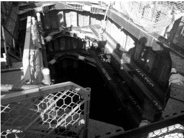
写真-4 推進工の発信立杭 仮設状況
