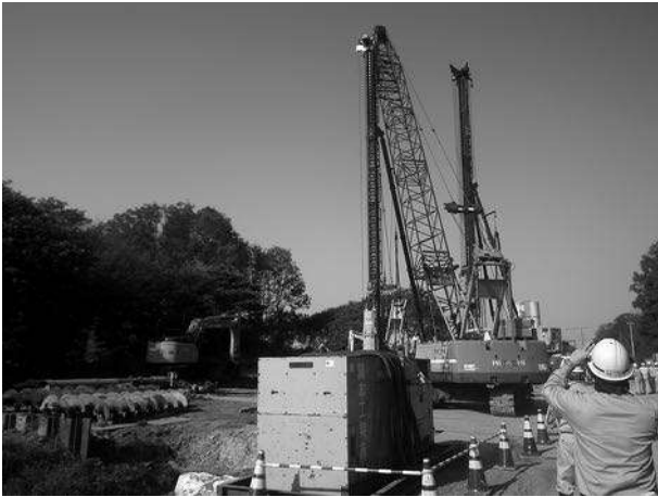
写真-3 スタンド工施工現場（杭打機）
