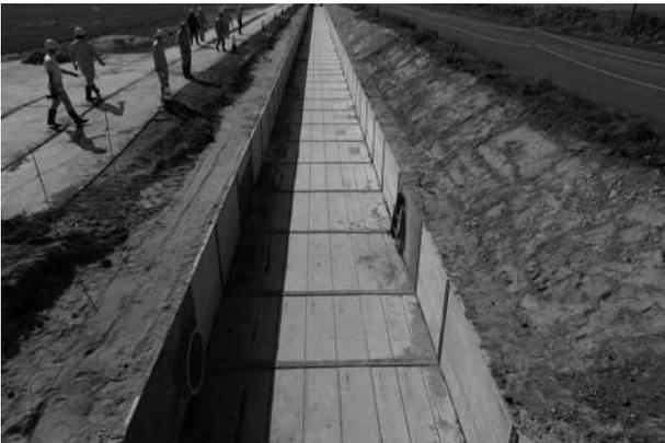
写真-5 排水路(コンクリート板柵渠)の施工状況
