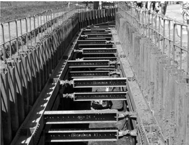
写真-3 鋼矢板土留工(切梁式)の仮設状況
