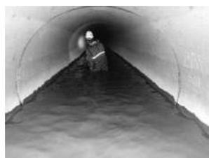
写真-5 不同沈下による滞水
