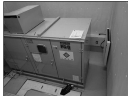
非常用発電装置
