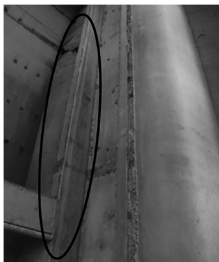
写真-4 調整ゲート戸当たりの接触痕
