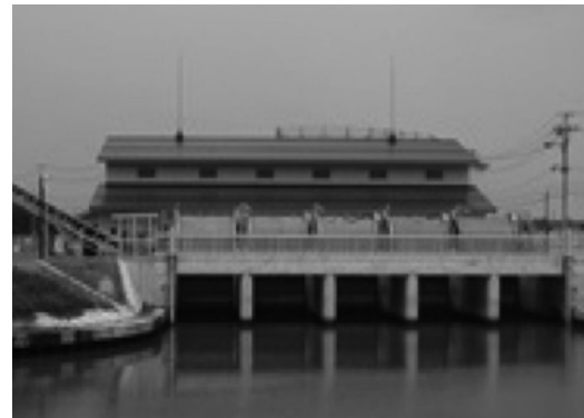
新川右岸排水機場の全景
