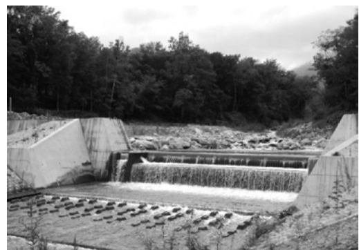
写真-3 災害復旧した石山頭首工 (チロール型式からバックストリーム型式に変更)
