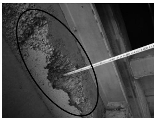
写真-3 取水塔の欠損、鉄筋露出
