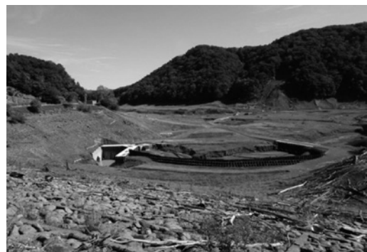
写真-1 被災した厚真ダムの復旧状況 (低水放流機能の確保工事が完了)
