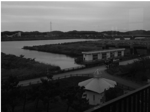
西川揚水機への取入口
