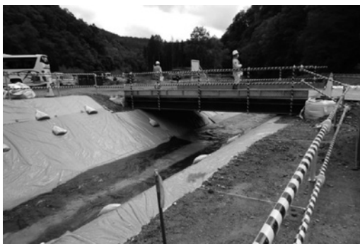
写真-4 ペンケニコロ川取水施設改修工事の施工状況 (仮廻し水路等の仮設状況)
