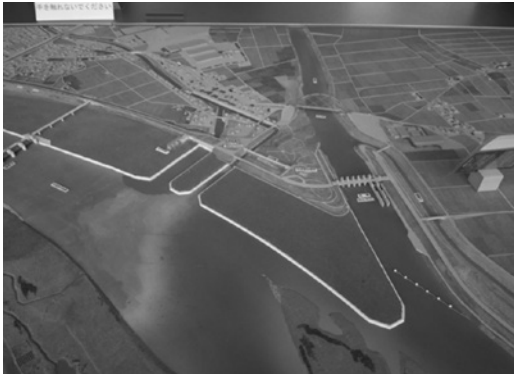
大河津分水地点の模型(信濃川大河津資料館)
