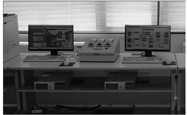
監視 Web 端末装置・操作パネル
