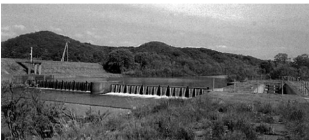
苦前頭首工(全可動フローティングタイプ)
