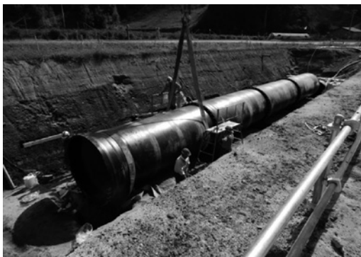
写真-2 被災した厚幌導水路の復旧工事 (S型ダクタイル鉄管の布設状況)
