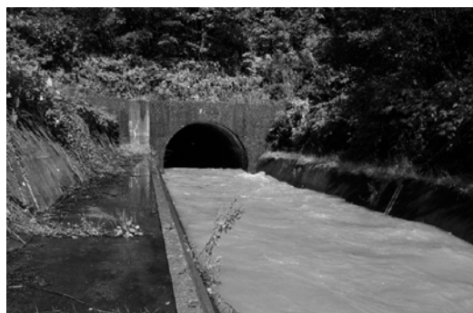
写真-5 トンネル出口現況写真
