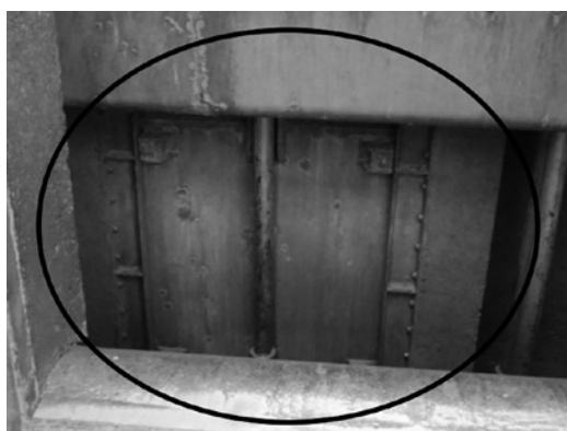
写真-2 取水ゲート扉体全体の発錆
