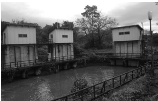
板倉調整池(ゲート操作による上江用水路等への分水)
