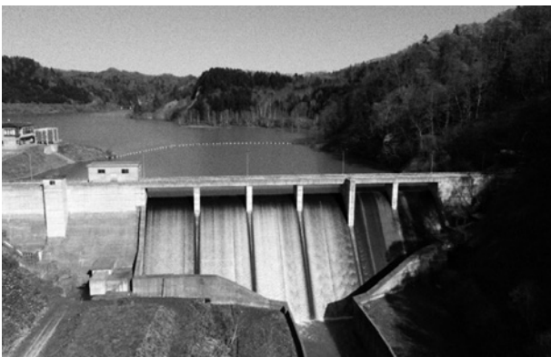
苦前ダム(重力式コンクリートダム)
