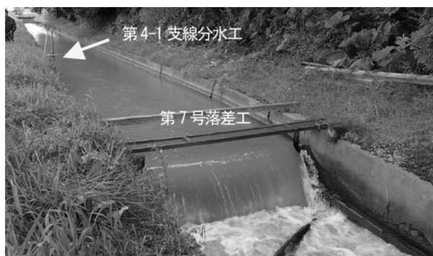
写真-5 第7号落差工
