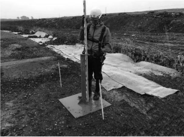
写真-5 沈下板設置状況
