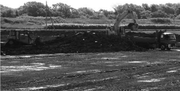
写真-6 基盤積み込み、搬出状況
