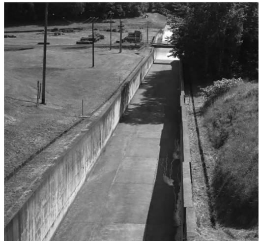
傾倒した雨煙内ダム洪水吐側壁
