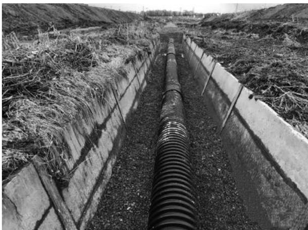
写真-2 ドレーン管敷設状況
