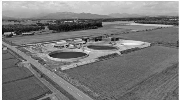
バイオガスプラント 牛のふん尿によるバイオガス発電とし、再生可能エネルギーの地産地消
