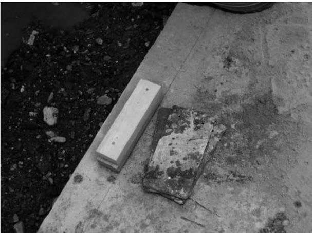
写真-5 施工敷高を調整するゴム板
