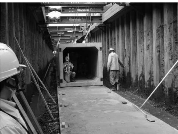
写真-6 施工敷高の確認作業
