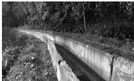
写真-4 日射ゾーンの水路全景
