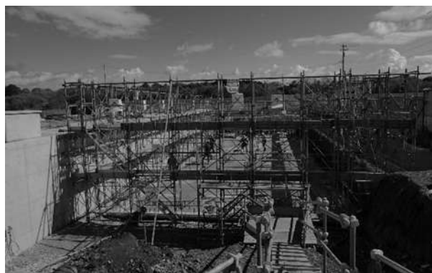
写真-7 美幌揚水機場の施工状況
