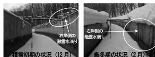
写真-11 水路の積雪状況(⑮スパン)
