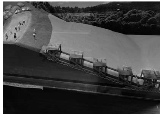
当時の堤体断面模型（手前が取水施設で「ゆる」が5段ある）
