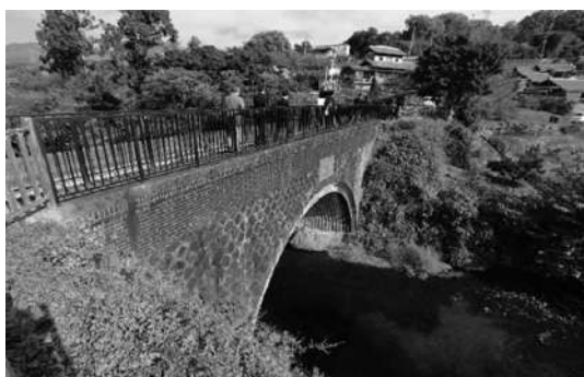
改修された現在の龍之渡井(レンガ・石張り造りのアーチ橋)
