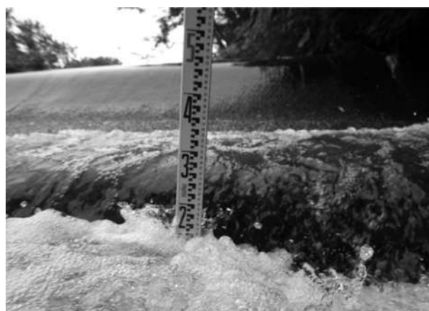
写真-2 エプロン部の洗掘状況
