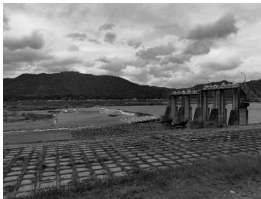
湛井堰(可動部は引上ゲート、固定部に魚道が3箇所)
