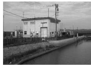
豊住排水機場 全景
