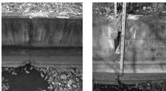
天端部の軽微なスケーリング 目地付近の欠損 写真-3 日陰ゾーンの劣化状況
