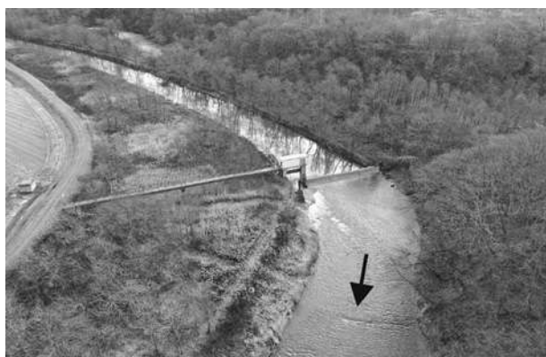
写真-1 金子頭首工全景
