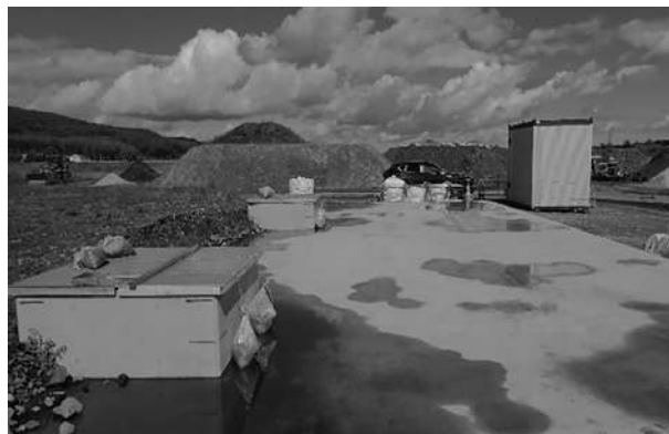
写真-6 美幌ファームポンドの施工状況
