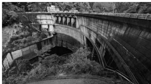
大迫ダムの全景
