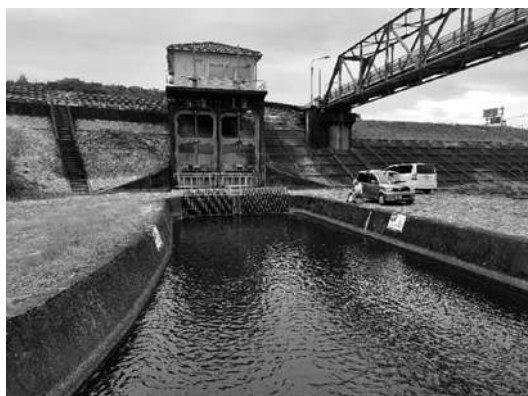
取入口(高水敷を開水路で引込んだ後に取水ゲートがある)
