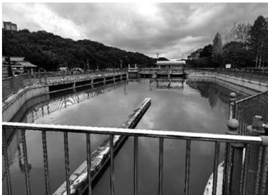
東西分水工（沈砂池）
