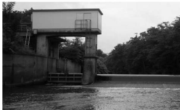
写真-5 金子頭首工土砂吐(下流側より撮影)
