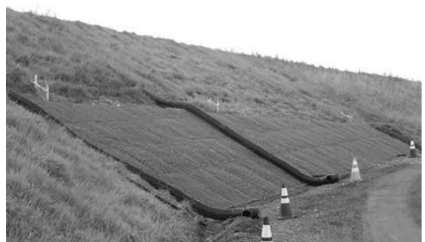
写真-5 法面保護工の施工状況
