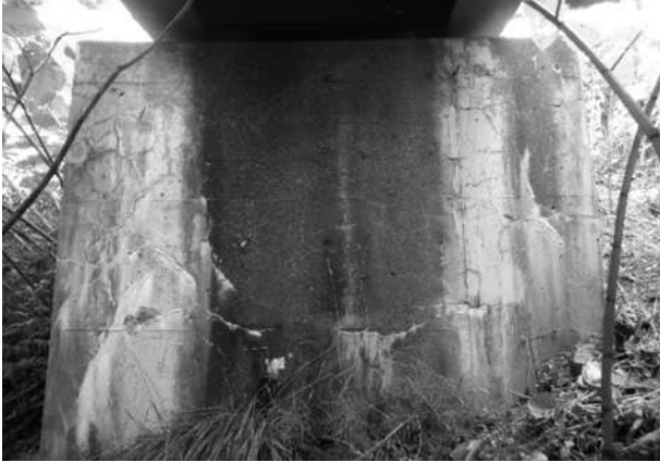
写真-3 橋台劣化状況
