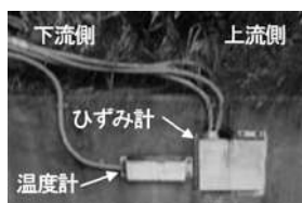
写真-10 計測機器設置状況
