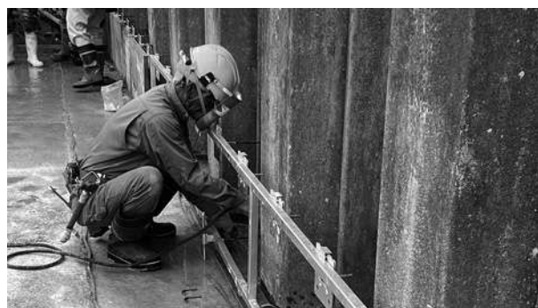
写真-1 鋼製定規枠に金具の設置作業状況
