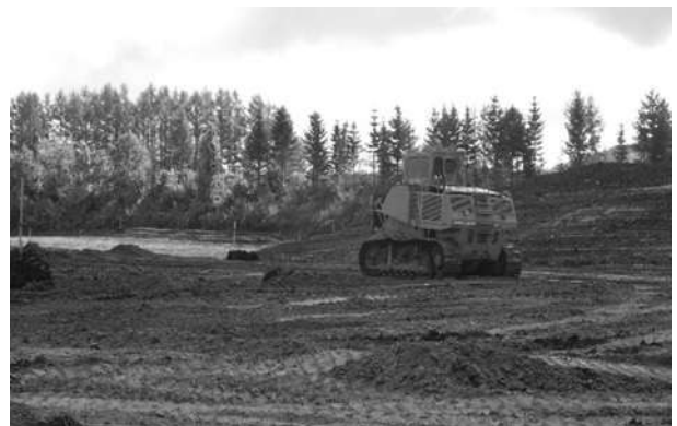
写真-4 スクレープドーザによる整地工の施工状況
