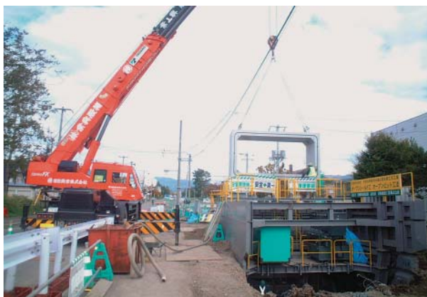
写真-3 暗渠工の施工状況
