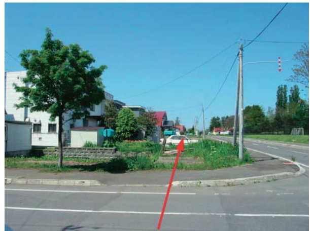
写真-2 暗渠工の周辺状況
