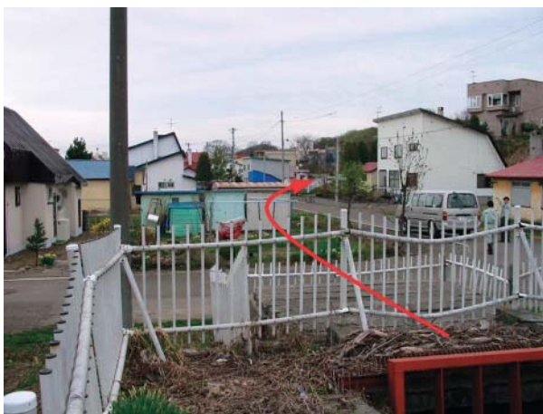
写真-1 サイホン工の周辺状況
