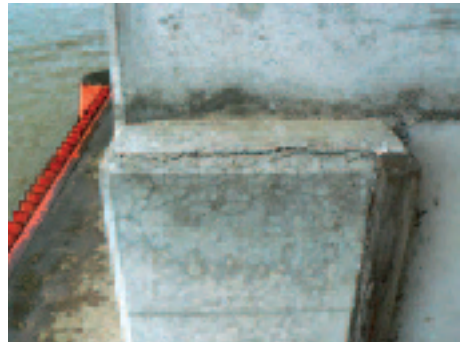
写真-1 ひび割れ
