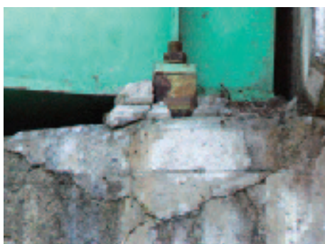
写真-25 管理橋 橋座部の状況
