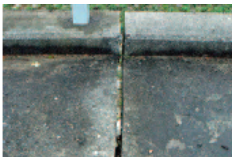
写真-23 管理橋継目
