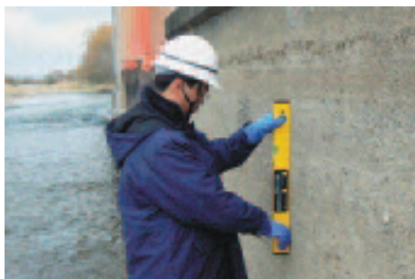
写真-15 擁壁の傾倒調査
