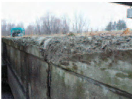
写真-19 擁壁天端に発生した凍害劣化
