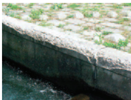
写真-3 凍害劣化の状況
