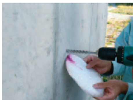
写真-12 ドリル法による中性化試験
