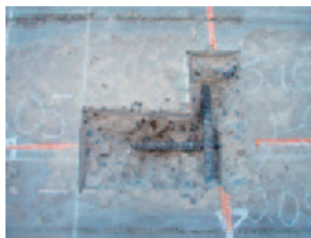
写真-13 鉄筋腐食状況の確認
