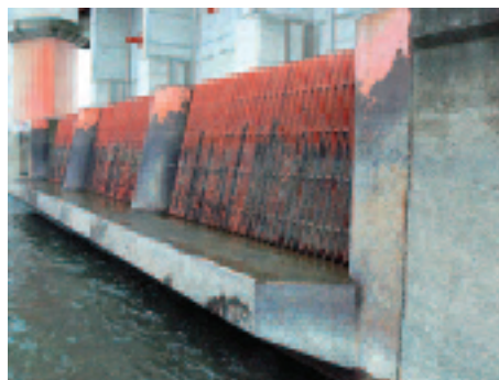
写真-26 鋼材による隅角部の保護
