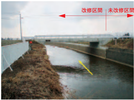
写真-4 Ni地点下流付近の水路状況
