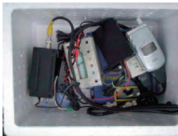
写真 - データ処理・電送装置内部
