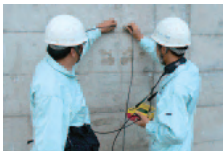
写真-6 超音波法によるひび割れ深さの測定
