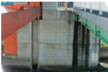
写真-24 堰柱側面の状況
