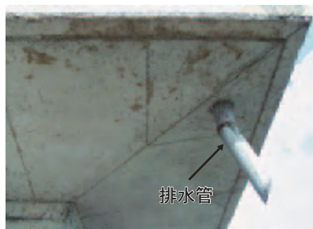
写真-20 堰柱頂版の排水管
