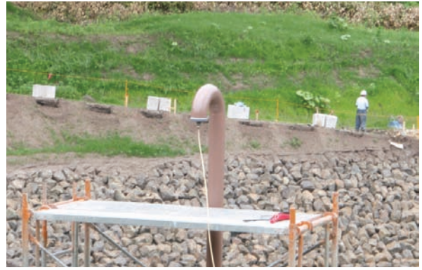
写真－１ 通気スタンドを利用した空気圧送状況
