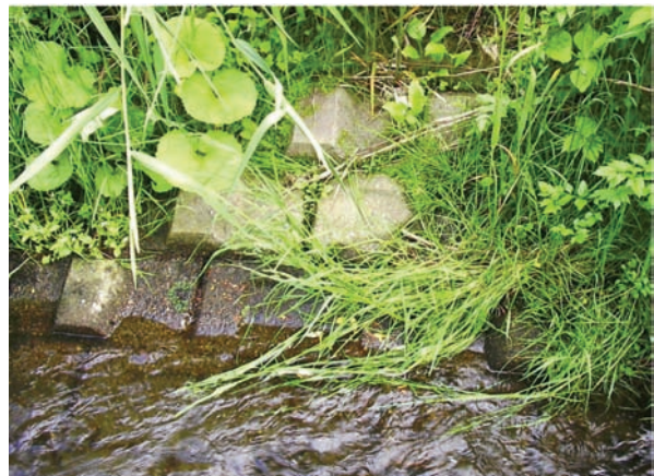
写真-2 既存護岸（連結ブロック）
