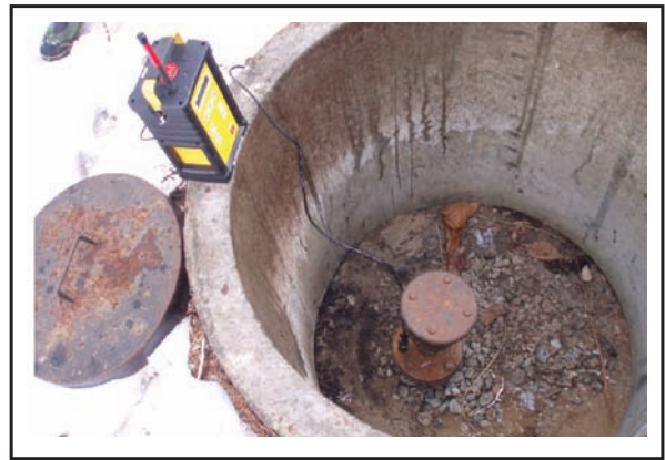
写真-2 センサーの設置状況 (空気弁工)
