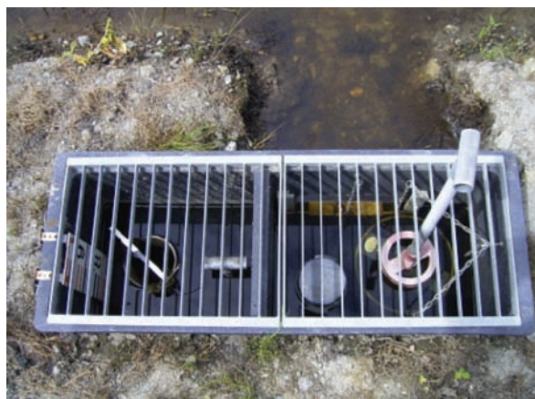
写真-1 ユニットの設置状況
