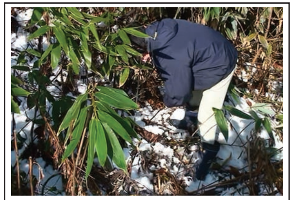
写真－5 音聴棒による音聴調査状況
