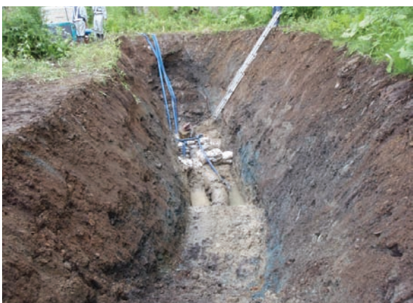
写真-3 開削部の全景
