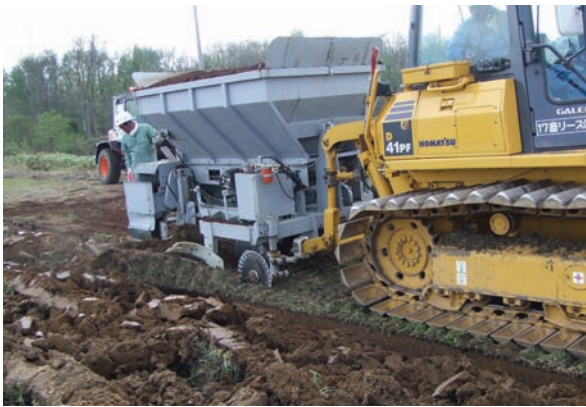
図4 有材心土破碎工の施工状況（オープナー式）
