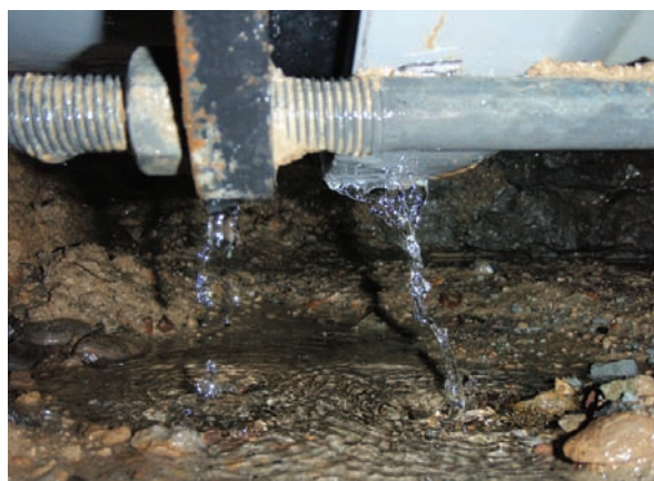
写真-5 伸縮継手部からの漏水状況
