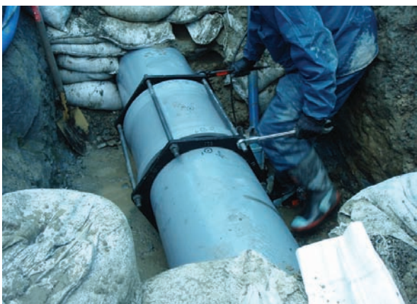
写真-4 伸縮継手部（KCジョイント）
