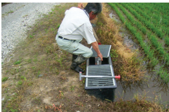
写真-3 水位調整の作業状況
