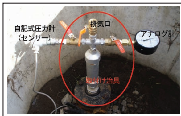
写真-1 治具と圧力計の設置状況
