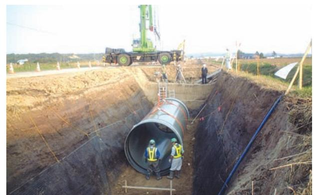
写真－6 新設管の埋設 (FRPM管)
