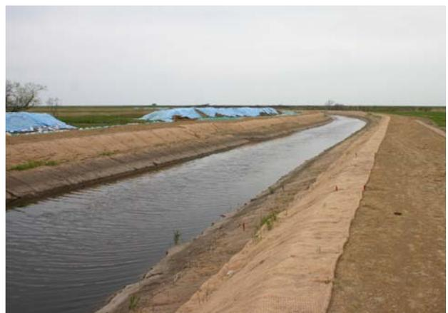
写真-3 天然素材シートによる法面被覆工
