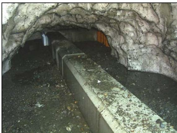
図-7 バイパス空洞の拡大後の写真
