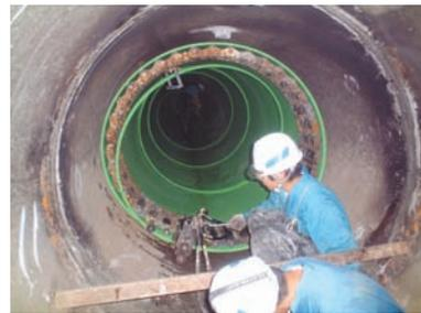
写真-9 製管作業
