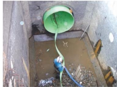
写真-8 製管材の挿入
