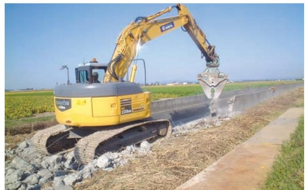
写真－5 既設水路の取り壊し状況
