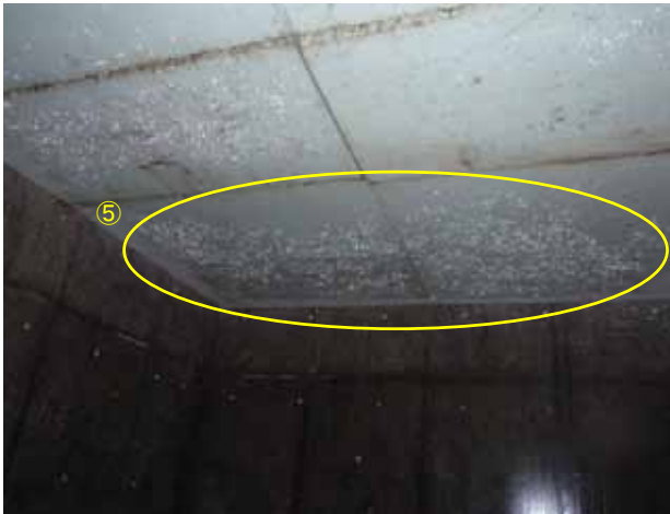
写真-1 弁室A 側壁と頂版断熱材の状況
