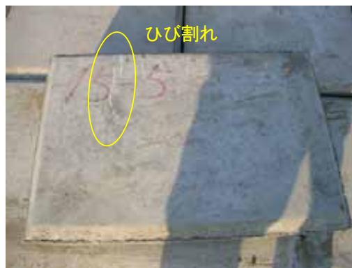
写真3.3.1 表面ひび割れの状況
