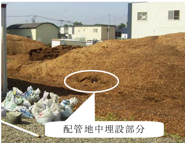
図-17 8月11日の地中埋設型配管と雪山の状況
