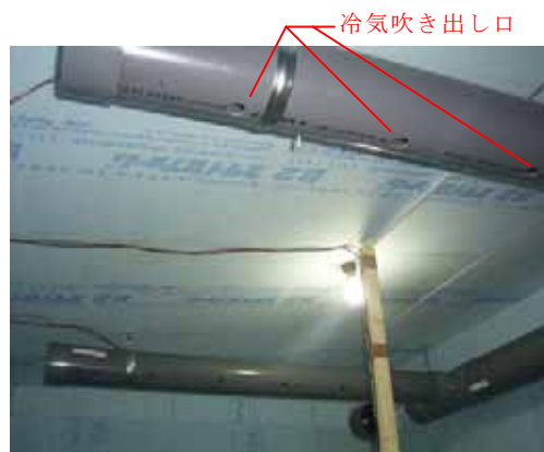
図-5 貯蔵庫内部の冷気吹き出口
