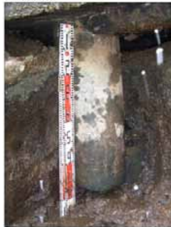
図2 試掘時の杭折損状況
