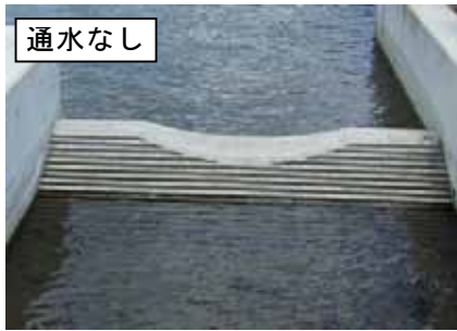
写真-1 スリット付きスロープ（半円切欠越流堰）
