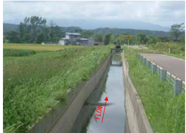
図1 用水路の傾倒状況
