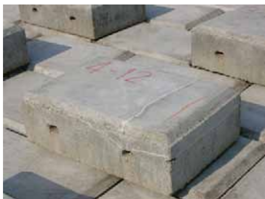
写真3.3.1 水平ひび割れの状況
