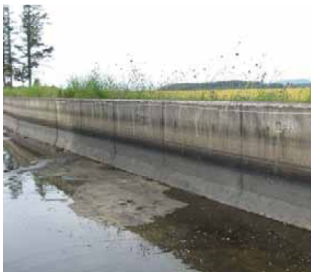
図6 側壁上部のスケーリング
