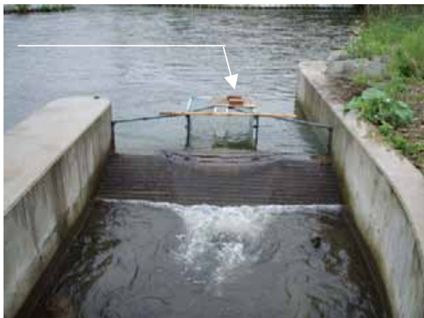
写真-2 トラップ設置状況
