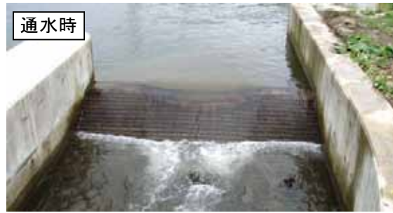
写真-1 スリット付きスロープ（半円切欠越流堰）
