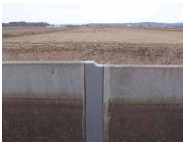
図9 PCフルーム振れによる目地のズレ補修
