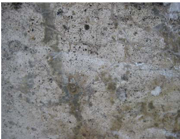
図5 側壁の亀甲状のひび割れ
