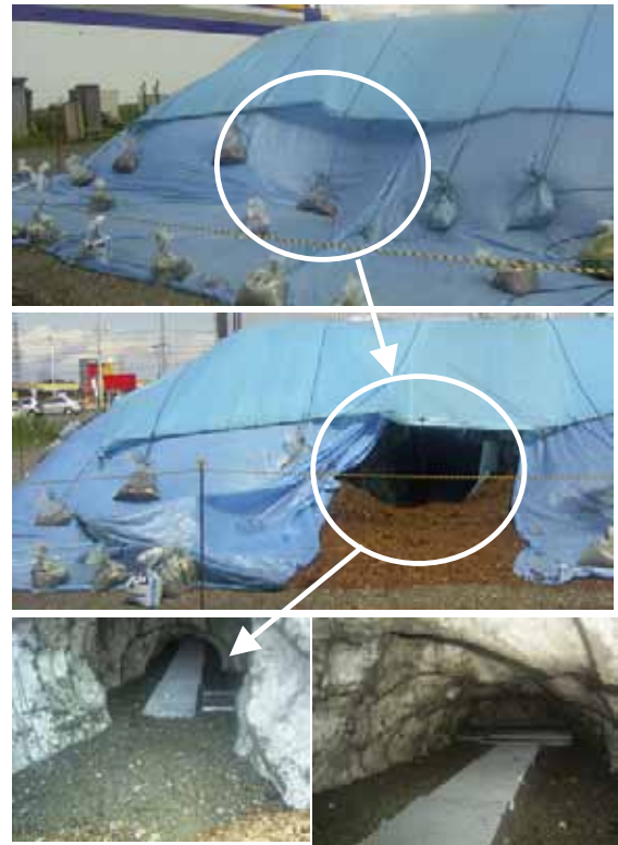
図－9 雪融解箇所の写真 (システムBの排水管の埋設箇所)
