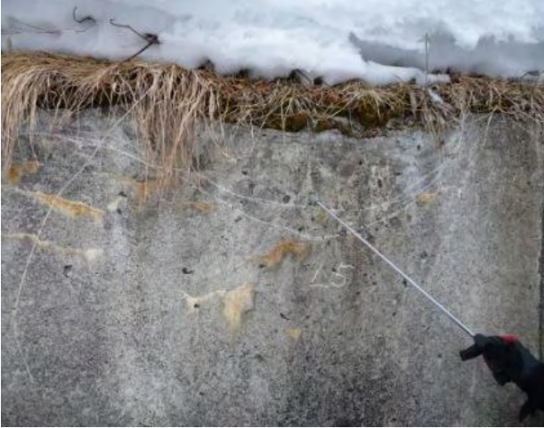
写真-5 凍害によるひび割れ
