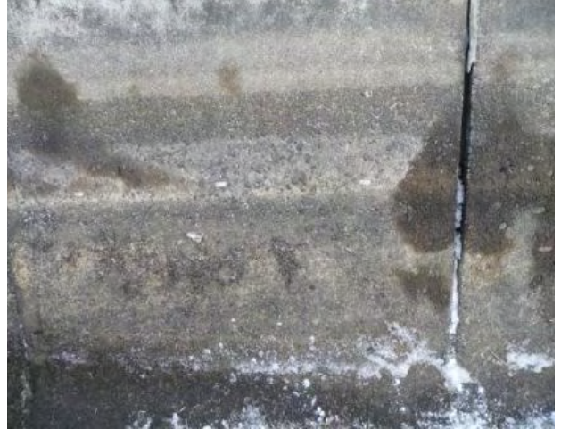
写真-2 目地の欠落
