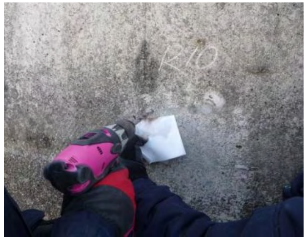
写真-8 中性化深さ調査
