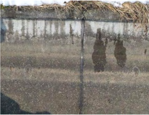
写真-1 鉄筋の露出
