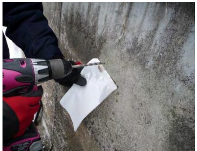
写真-4 中性化深さ調査
