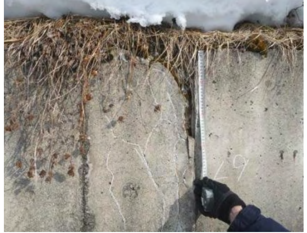
写真-6 目地部のひび割れ
