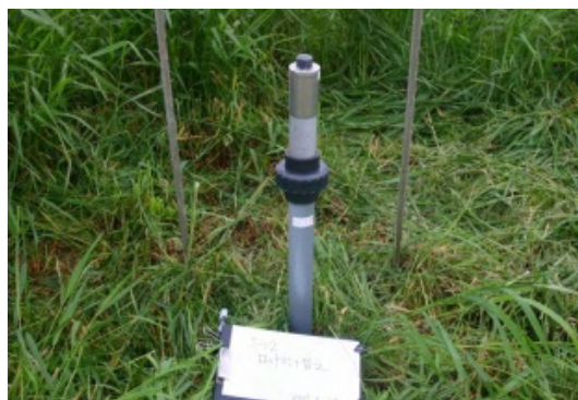
図-6 上から：沈下板、スタッフ設置、長ロッド、短ロッド
