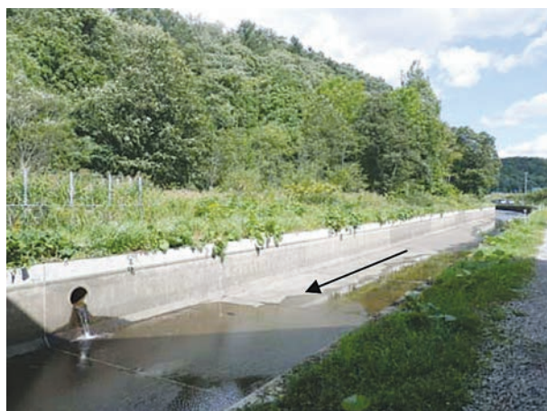
写真－1 改修前の右岸形状
