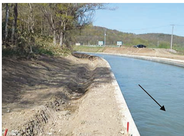
写真－2 改修後の右岸バーム
