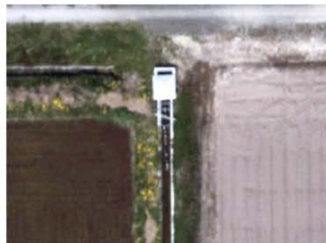
—既設水路（開水路）起点部柵—
