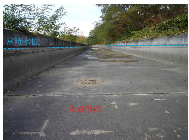
写真－2 底版の状況（踏査区間－1 SP2800付近）
