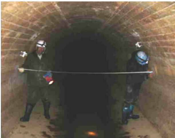
写真-1 山部トンネル（SP. 1, 600付近）
