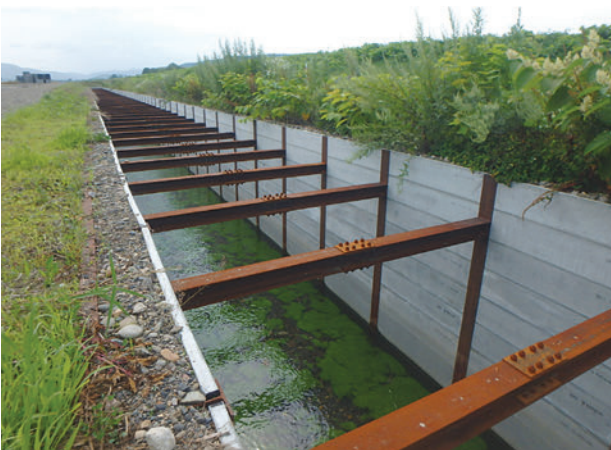
図－12 施工後写真（水路高3.0m区間）
