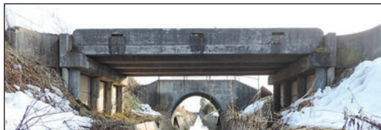
写真－1 CTスラブ橋（手前）とコルゲートアーチ橋（奥）
