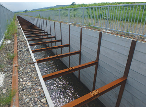
図－13 施工後写真（水路高4.0m区間）
