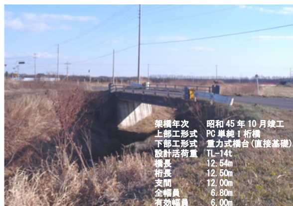
写真－1 既存のうづき橋
