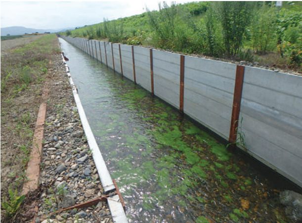
図－11 施工後写真（水路高2.0m区間）
