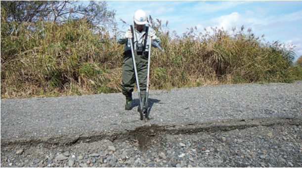
写真－8 土砂サンプリング状況
