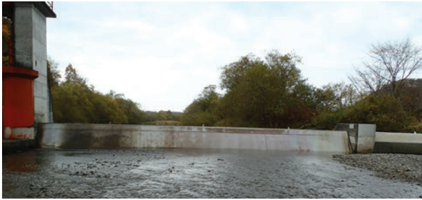
写真-3 中央の洪水吐ゲート 扉体上流面（全体）
