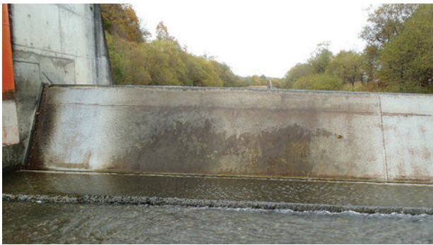
写真-4 中央の洪水吐ゲート 扉体上流面（左岸側拡大）
