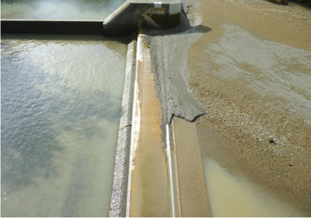
写真-11 中央ゲートの状態
