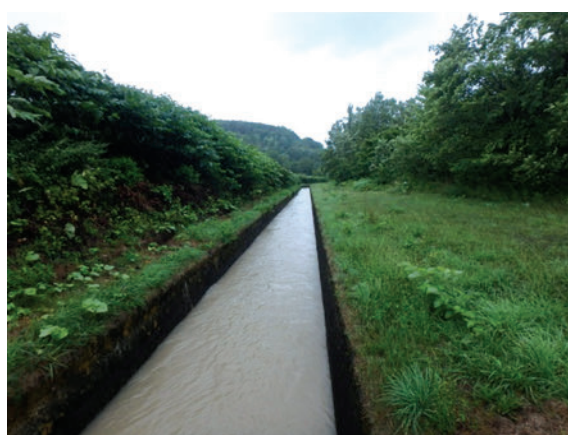
写真-3 山部幹線用水路・施設計画地点
