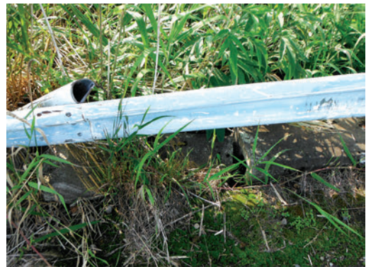
写真－3 防護柵の破損状況
