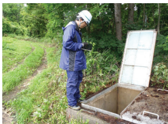
写真-4 PCを使用した調査状況
