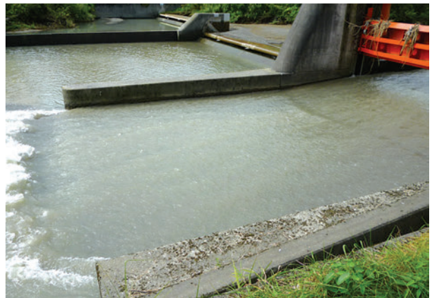
写真－10 土砂吐からの流れの状態
