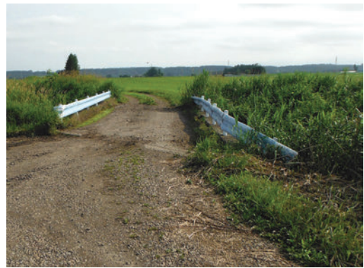
写真－2 中鹿幹11号橋 全景
