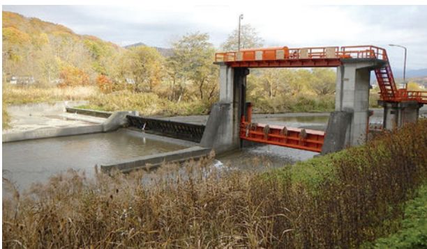
写真－1 U頭首工全景
