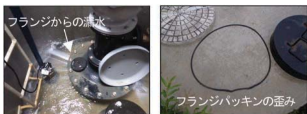
写真-2 空気弁工の漏水事例
