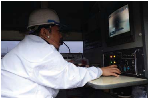
写真-5 管内面のモニター確認状況
