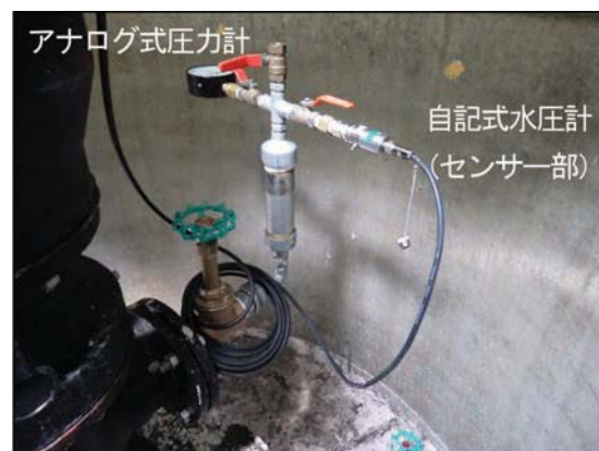
写真-3 自記式水圧計の設置事例
