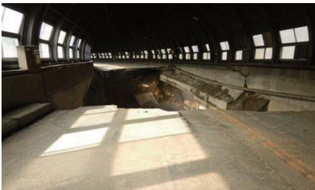
写真－1 三国の沢覆道内部の道路陥没
