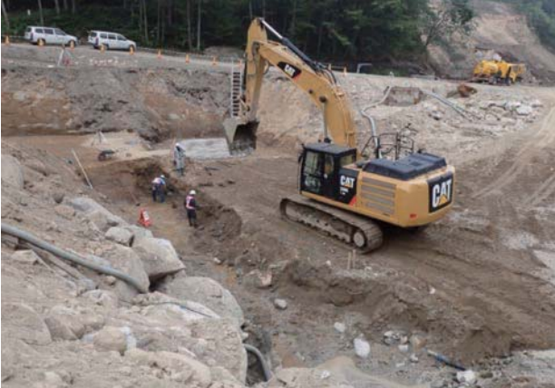
写真－6 御影地区土砂掘削状況
