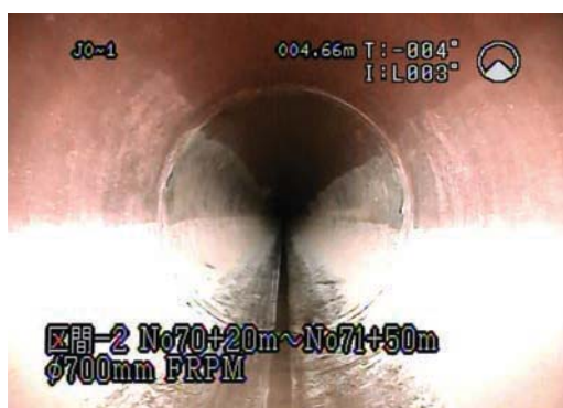
写真-11 ひび割れ・蛇行・沈下等なし
