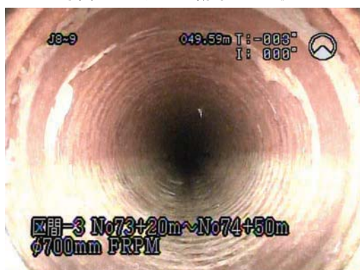
写真-15 被膜の剥がれ
