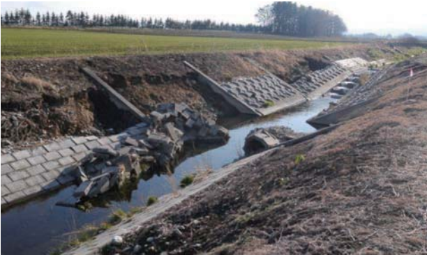
写真-10 明渠排水路の護岸ブロック破損
