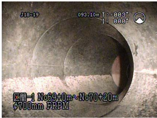
写真-24 鋼製異形曲管 (No. 69+32.60)
