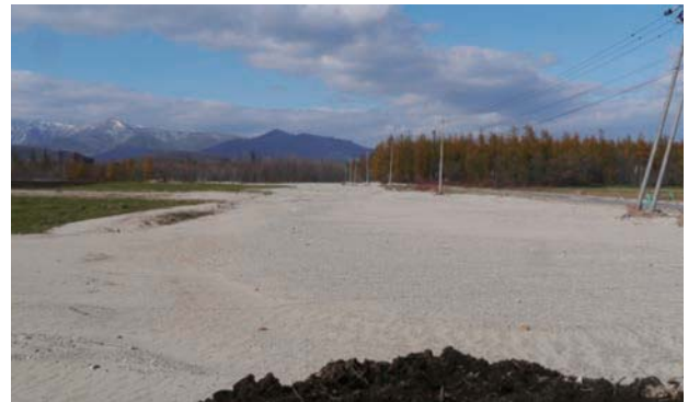
写真－8 清水町御影の土砂が堆積した農地
