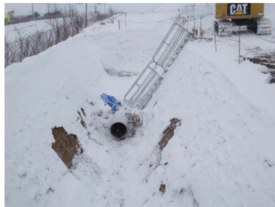
写真-22 調査時の管体露出状況
