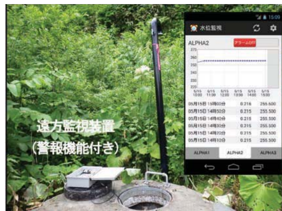
写真-4 遠方監視装置の使用事例 スマートフォンアプリ(自社開発)による監視例
