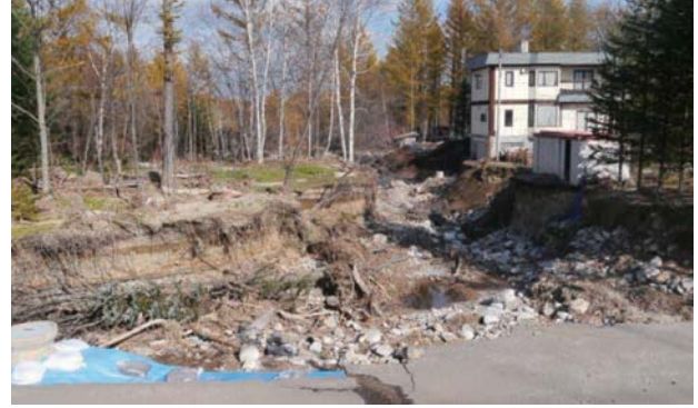
写真－7 侵食溝は農家の基礎に迫っている
