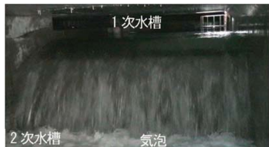
写真-5 落水水脈による気泡の発生事例
