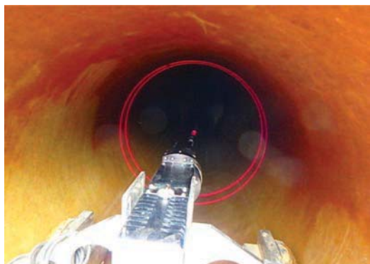
写真-19 管内面調査機械（ダブルリングレーザー照射状況）
