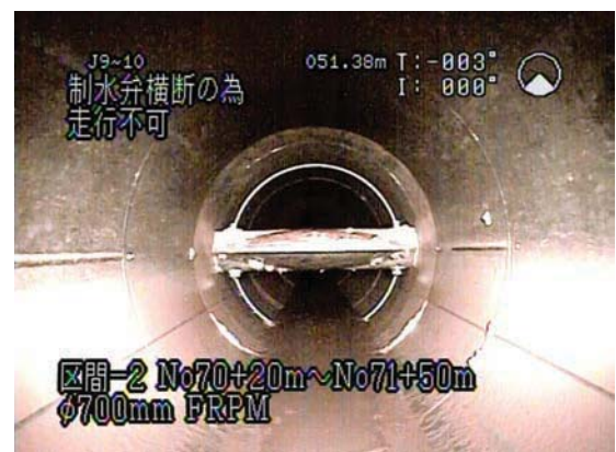
写真-25 第4号制水弁工の弁体 (No. 70+86.80)
