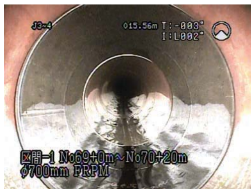
写真-20 鋼製異形管との接続部
