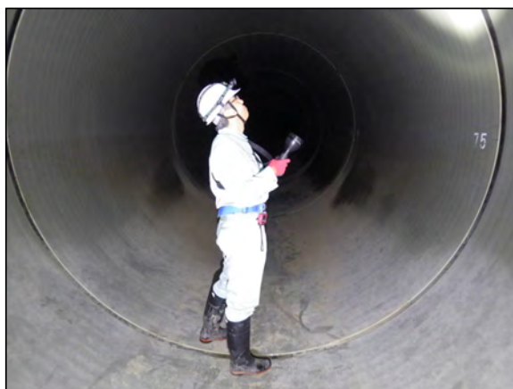
写真-2 目視点検状況
