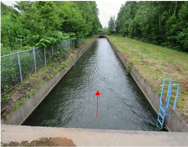
写真一 2 既設用水路全景
