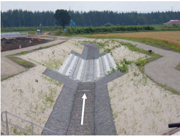
写真－4 完成写真（台形断面 下流区間）
