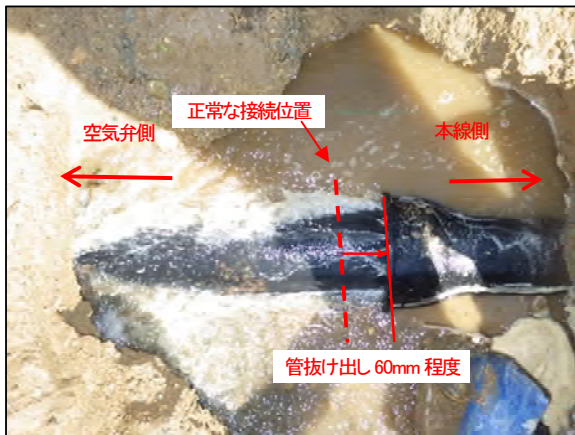
写真－6 立ち上がり管からの漏水状況 3) (安平－3 空気弁工)
