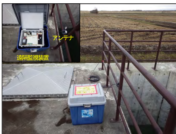
写真－4 遠隔監視装置と監視アプリ
