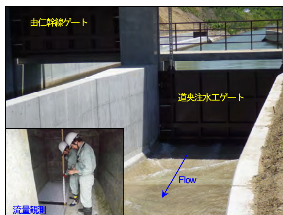
写真－5 道央注水工分土工のゲート操作と流量観測
