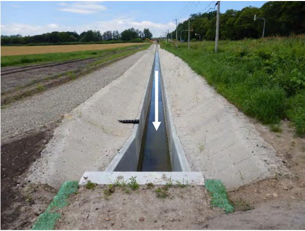
写真－3 完成写真（フルームA区間）
