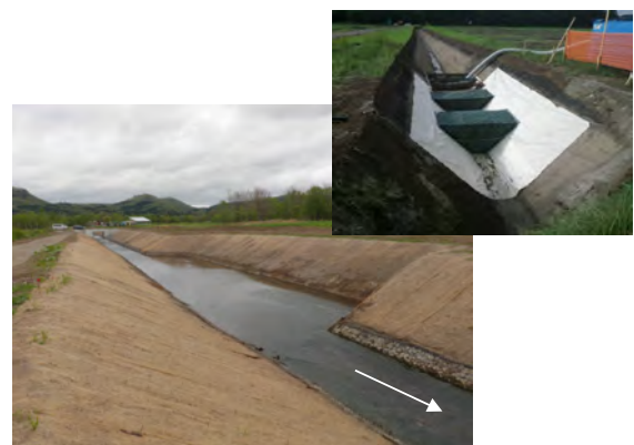
写真－6 沈砂池（左下）及び濁水処理施設（右上）
