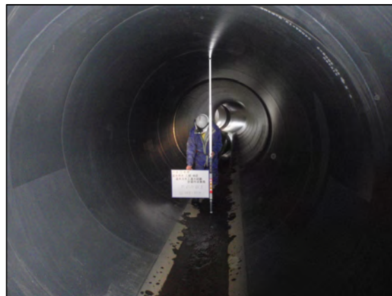
写真-3 たわみ量の計測状況
