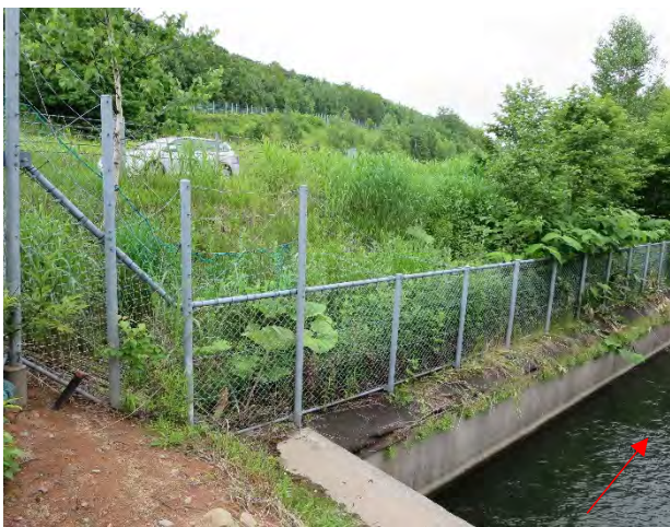
写真一 3 高速道路法面部
