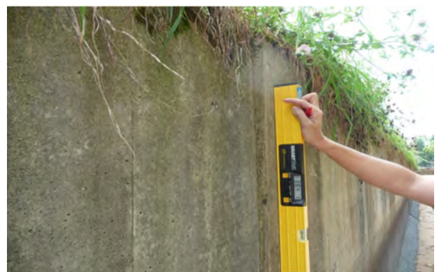
写真－1 傾斜計による傾斜角度の計測状況
