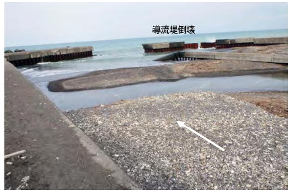
写真－1 河口施設の一部が倒壊している
