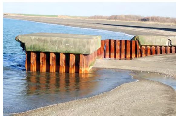
写真－2 河口施設 導流堤倒壊（近景）
