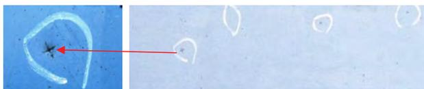
写真-8 落水時に鳥害による目地材に生じた穴の事例(JA-2)
