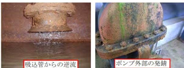
図-3 ポンプ設備の劣化状況一覧表
