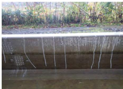
写真－5 B工法の近接目視調査時写真
