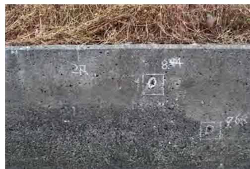
写真-3 側壁摩耗状況 (FA-1区間)
