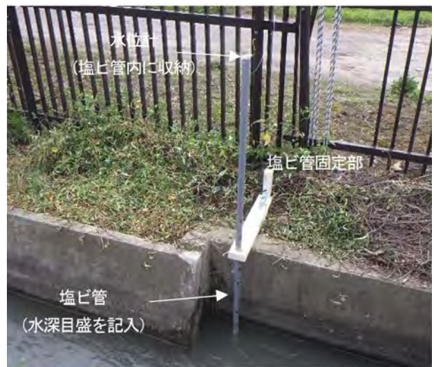
図-14 水位計の設置状況
