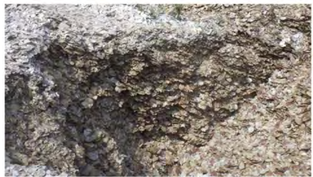
写真-17 試掘内部状況
