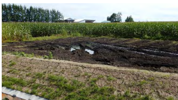
写真-4 低位部のほ場で湧水する状況(発注者提供)
