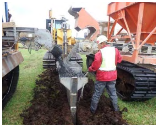
写真-2 疎水材2種類投入状況 1)
