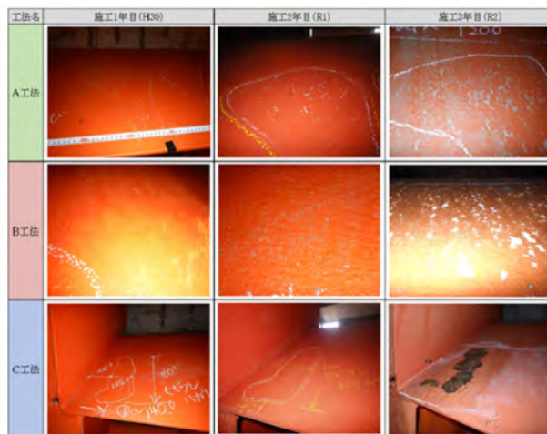
図-11 越流部の表面劣化進行状況
