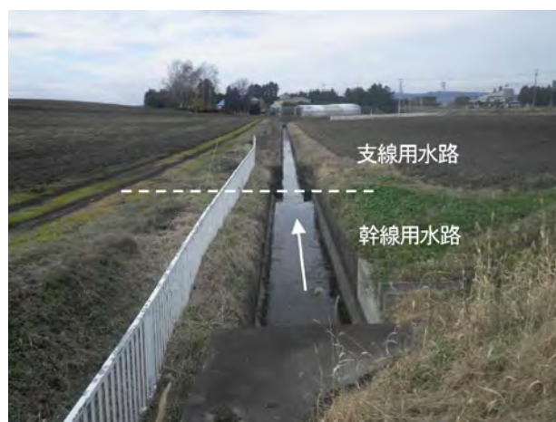
図－8 幹線と支線の分水構造
