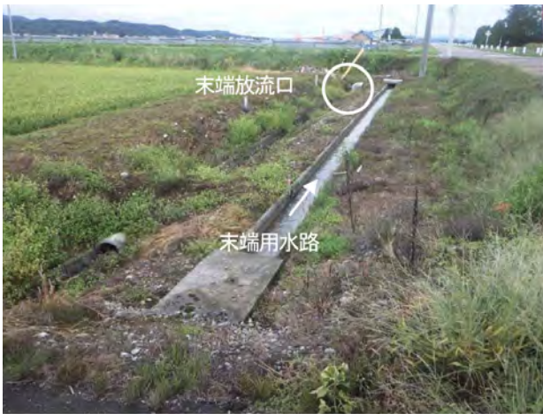
図-10 末端の分水構造
