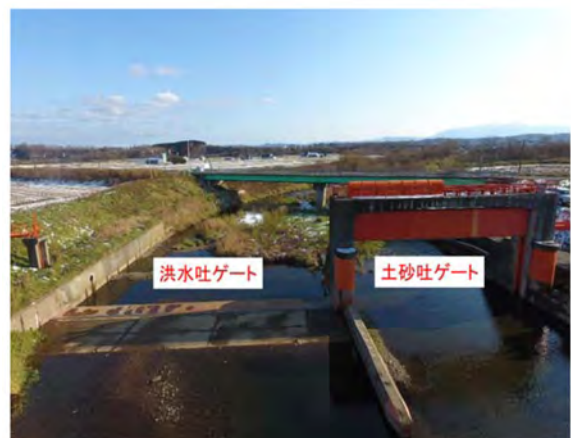
図－3 丹羽頭首工全景（上流から下流方向）
