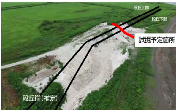
写真-9 幌内堆積場(2019/07/18の画像(北側堆積場))
