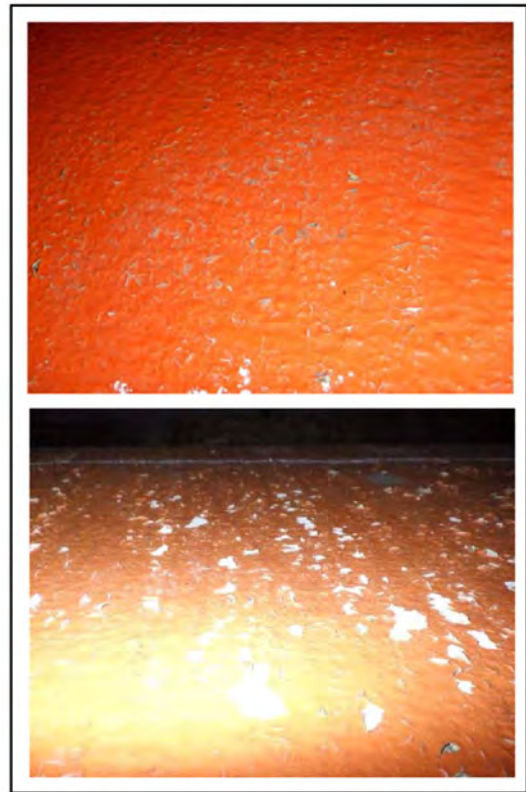
図-8 B工法越流部の剥がれ進行状況 (上2年目、下3年目)
