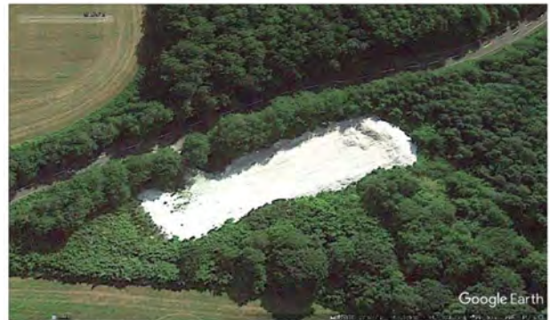
写真-4 沢木堆積場 (GoogleEarthより)
