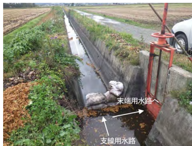
図－9 支線と末端の分水構造
