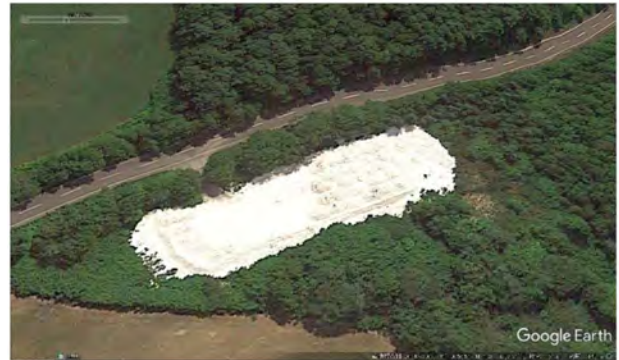
写真-11 沢木堆積場(2014/07/30の画像(GoogleEarthより))
