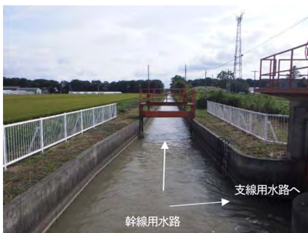
図－6 幹線と支線の分水構造
