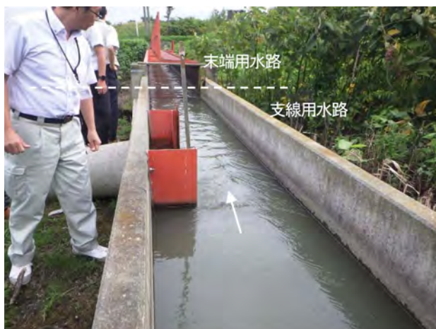
図－7 支線と末端の分水構造
