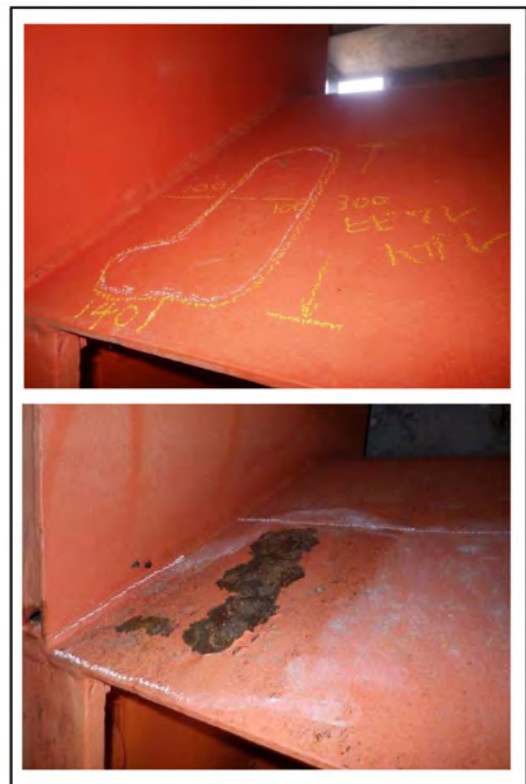
図-9 C工法越流部の剥がれ進行状況 (上2年目、下3年目)
