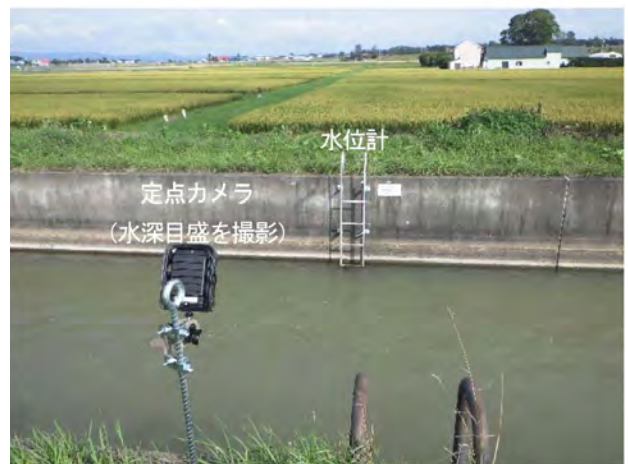
図-13 定点カメラの設置状況
