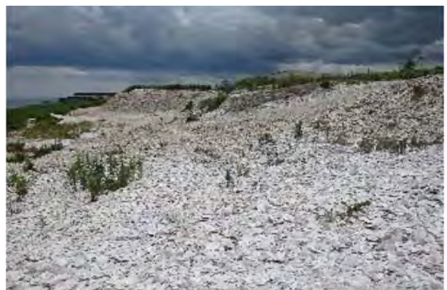
写真-14 幌内堆積場 (北側)
