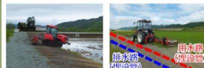
農機の旋回を容易にし、作業効率を向上させるターンの農道の整備
