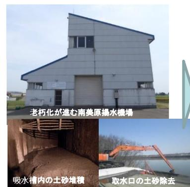
施設の老朽化と土砂堆積により維持管理負担が増
