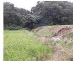
原形復旧したため池の堤体が豪雨で再度被災
