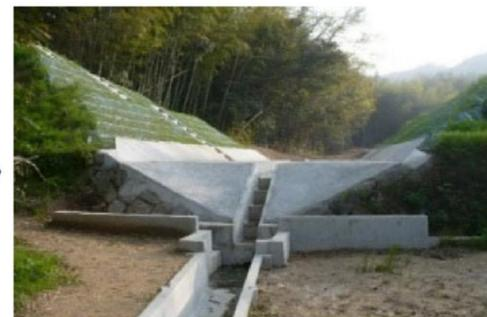
開削した法面の保護、護岸や下流水路の整備等、廃止工事の実施
