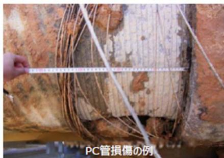
PC管損傷の例
