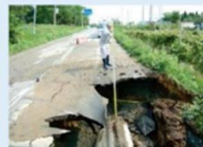
パイプライン破損による道路陥没
