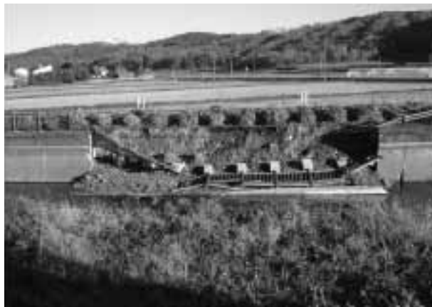
▲北海幹線用水路の擁壁倒壊地点(赤平)
