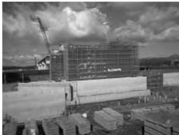
石狩川頭首工第3期建設工事 現場状況
