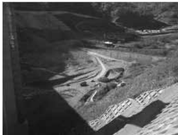
徳富ダム 上流側施工状況
