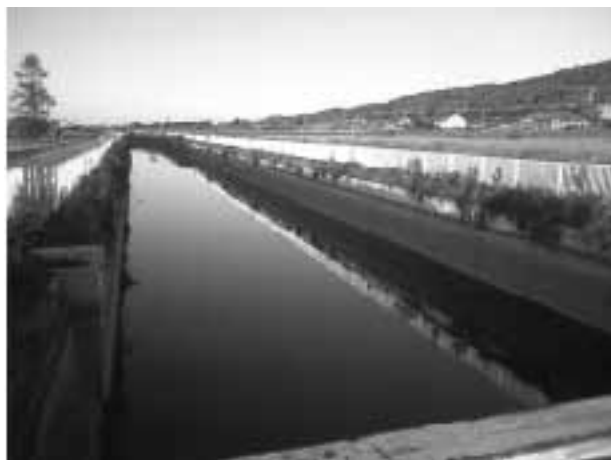
北海幹線用水路 空知中央地区整備区間
