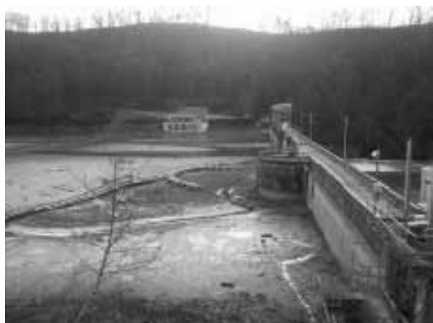
川端ダム及び道央注水工取水口
