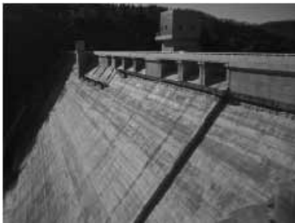
徳富ダム 堤体工
