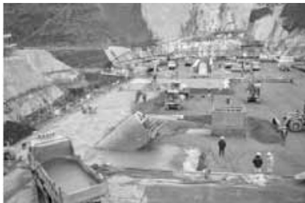
R C D工法施工状況
