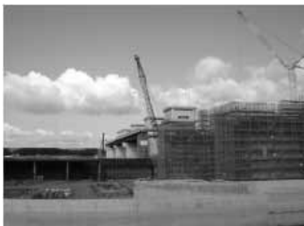
▲石狩川頭首工工事現場
